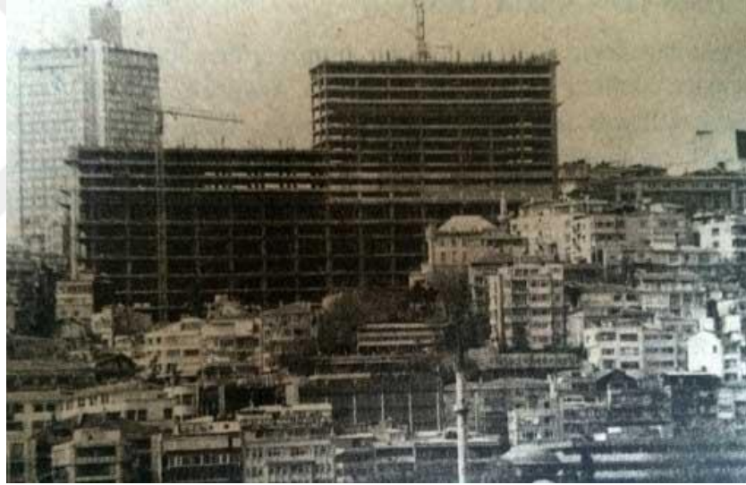
Şekil 2. 9 Park Otel'in yıkımdan önceki durumu [24]
