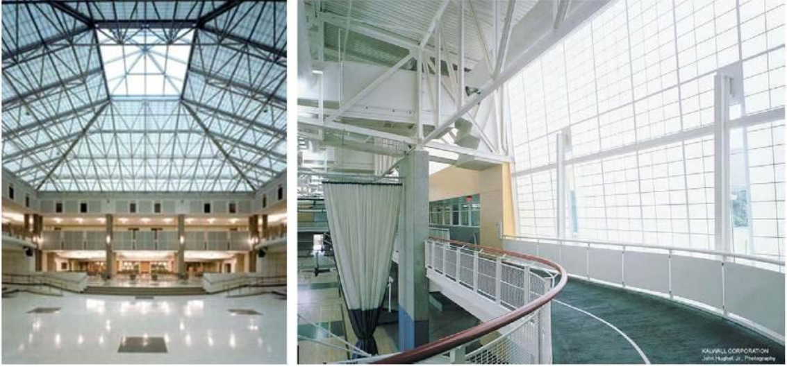
Şekil 3. 11 Günüşü için yüksek termal izolasyon performansı gösteren iki adet yarı saydam aerjel izolasyon örnekleri [41]
