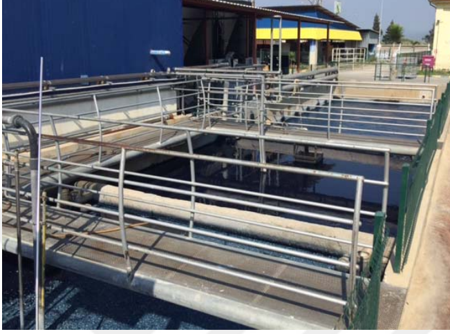
Şekil 2.1 Bir denim ürün yıkama işletmesine ait atık su dinlendirme alanı
