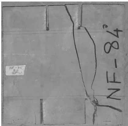
Resim 7.23. NF-84 numunesinde çatlak yörüngesi
