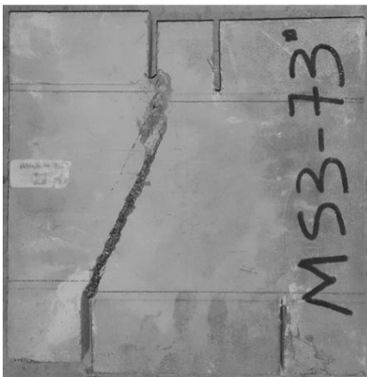
Resim 7.15. MS3-73 numunesinde çatlak yörüngesi
