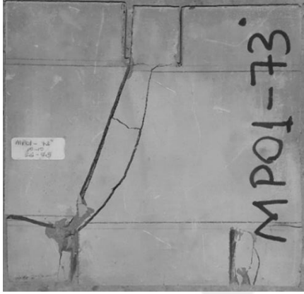
Resim 7.10. MP01-73 numunesinde çatlak yörüngesi
