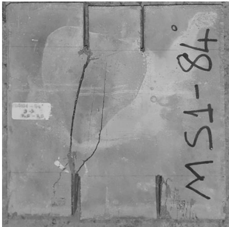
Resim 7.27. MS1-84 numunesinde çatlak yörüngesi
