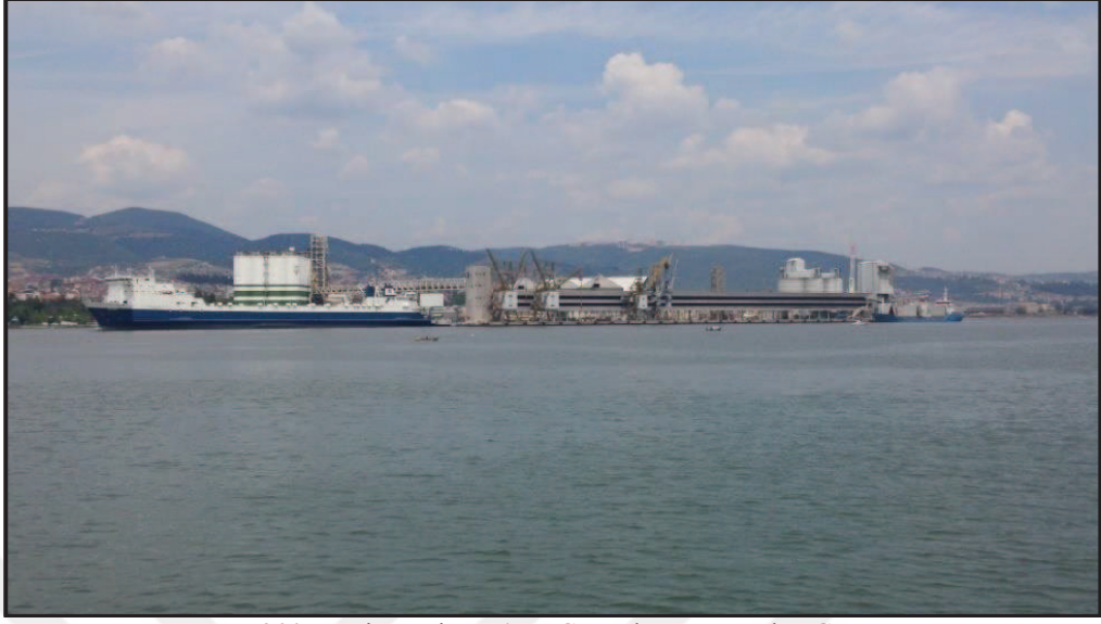
Fotoğraf 20: Derince Limanı'nın Güneybatı Yönünden Görünümü.
