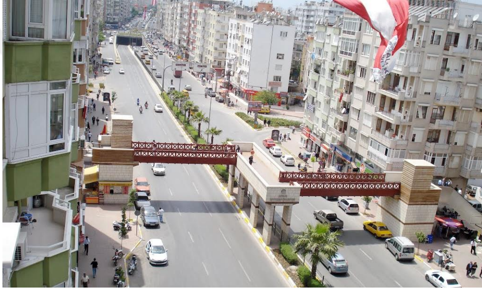
Şekil 3.13 Çalışma alanının kuzeyinde yer alan bir yaya üstgeçidi [68]
