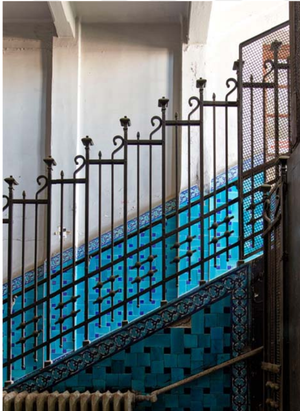
Şekil 96: Mesadet Han merdiven ve koridorlarındaki lacivert-firuze sepet örgüsü biçimli çiniler. (Cemal Emden, 2015)
