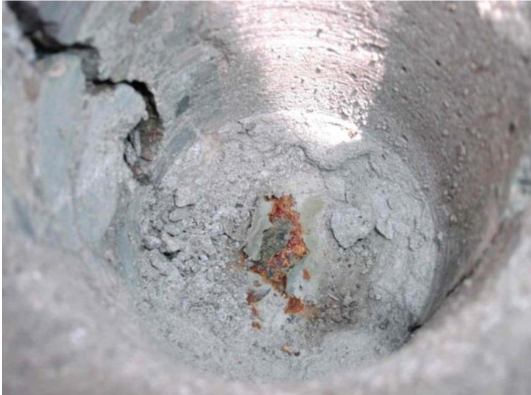
řekil 4.46 : Yakın zamanda alınmıř bir karot numunesinin i kısmında, epoksi kaplamanın altında korozyon rnlerini gsteren grnt [33].
