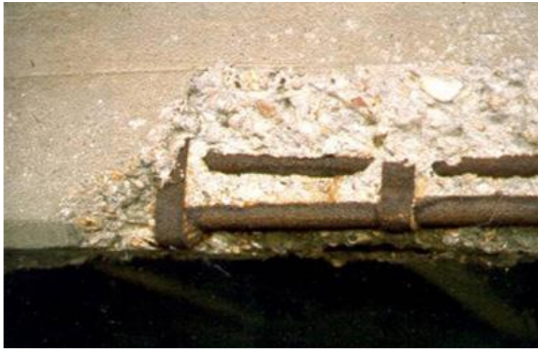
Şekil 3.12 : Karbonasyona uğramış metal.
