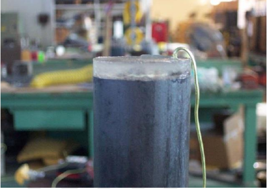
Şekil 4.7 : Döküm işleminden önce bağlantıların epoksi ile kapatılması [33].
