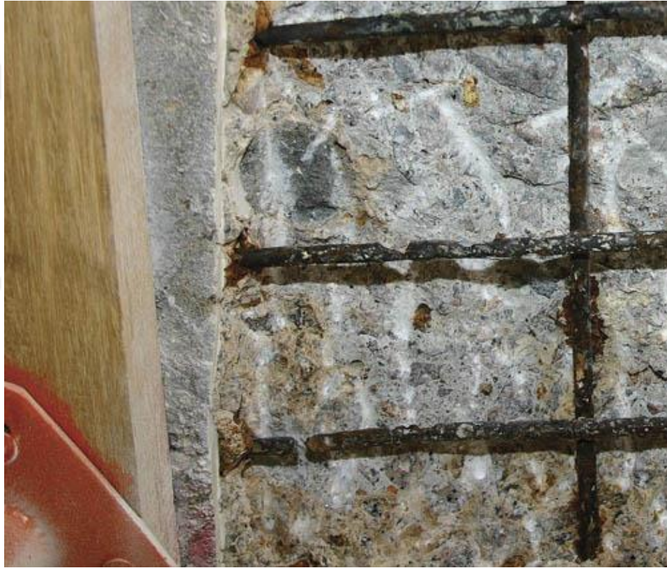
Şekil 3.17 : Donatı çapındaki kayba örnek.
