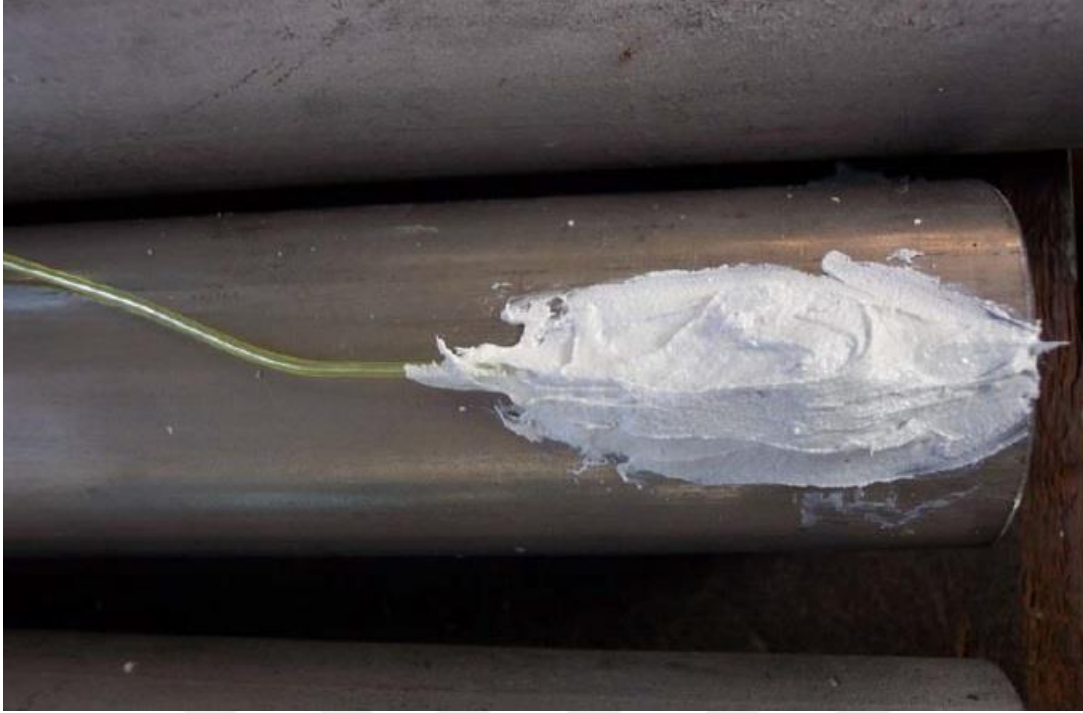
Şekil 4.9 : Döküm öncesinde bağlantının epoksi ile kaplanması [33].
