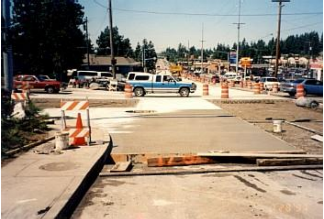
Şekil 2.3 : Sabit kalıp kullanımı [3].
