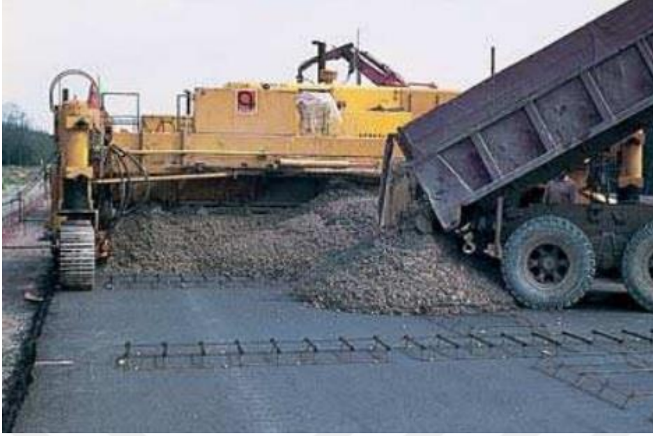
Şekil 2.1 : Kamyonla taşınan beton ile yol yapımı [3].
