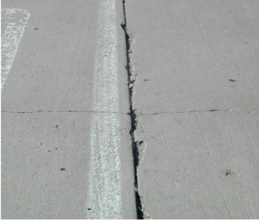
Şekil 3.30 : Betondaki kırılmalar.
