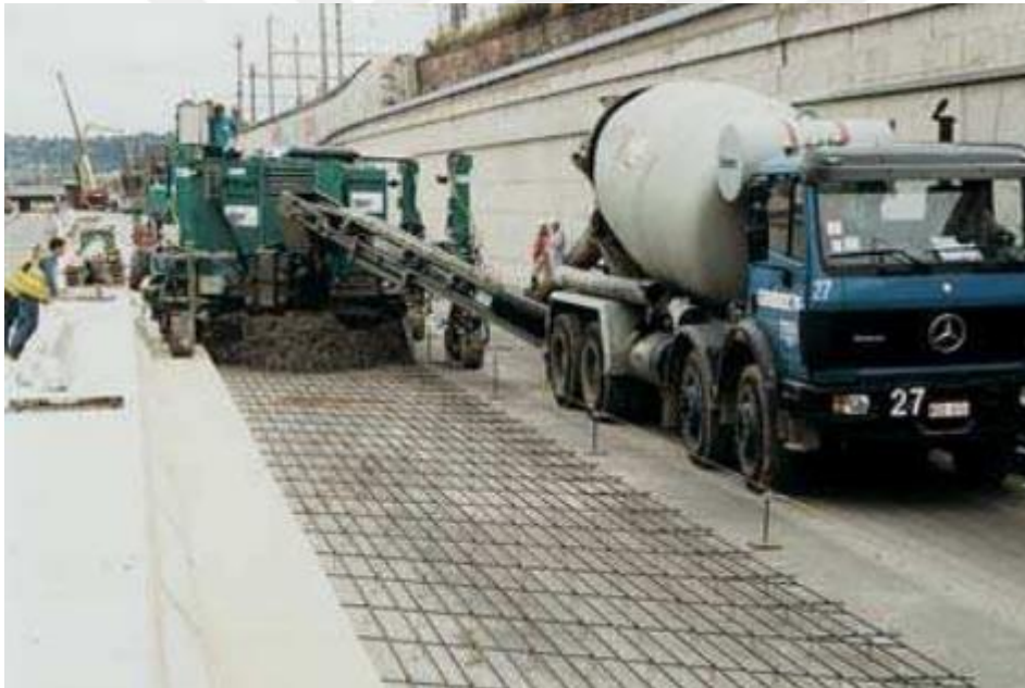
Şekil 2.2 : Transmikser ile taşınan beton ile yol yapımı [3].
