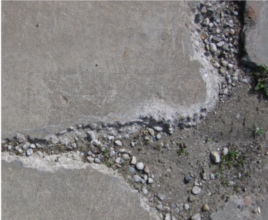
Şekil 3.31 : Betonun parçalanması.
