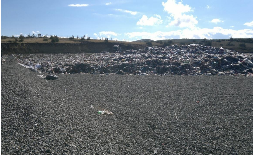
Şekil 2.1. Bingöl ili katı atık depo sahası araziye taşınmış katı atıklar (orjinal)
