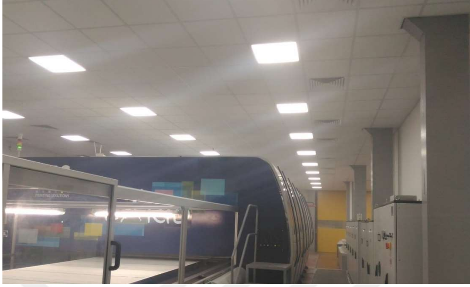
Şekil 6.18. Led armatürlerin 300 lüks analizine göre yerleştirilmiş hali
