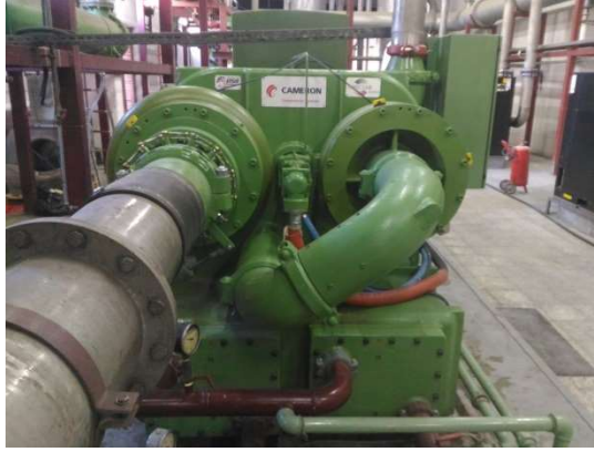
řekil 6.12. Revizyon sonrası TA-6000 turbo kompresör airenđ ünitesi
