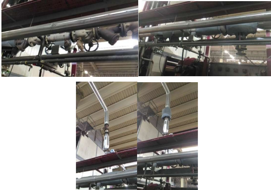
Şekil 6.21. Vana ceketi uygulaması öncesi ve sonrası fotoğraflar
