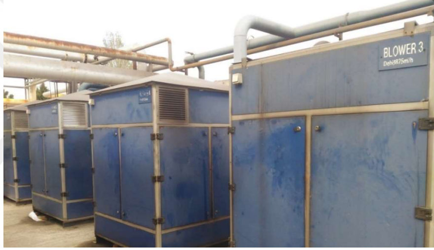
Şekil 7.2. Tesiste bulunan her biri 1875 m 3 /h emiş debisine sahip blower kabinleri
