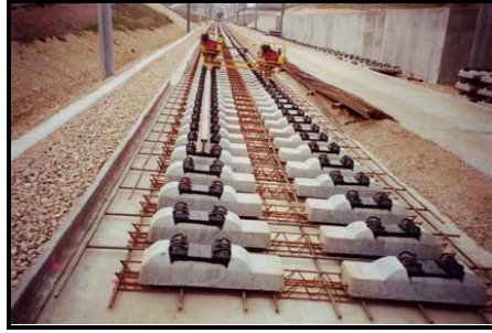
Şekil 2. 5 Beton içine gömülü tip balastsız üstyapı [8]
