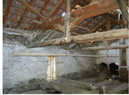
Şekil 3.68. Kayı Köyü-2 sakanasının çatı makaslarına asılmış kurutma askısı.
