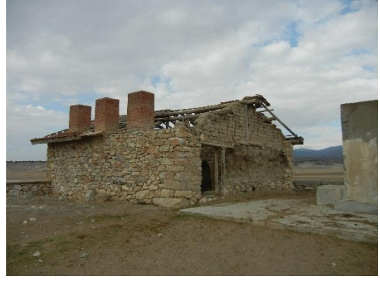
Şekil 3.44. Karageyikli Köyü sakanası.
