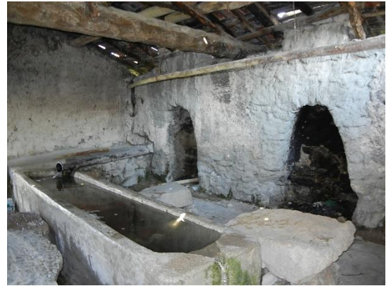
Şekil 4.9. Ocakları tek duvar üzerinde yer alan Yukarı Dođanođlu Köyü sakanası iç mekânı.
