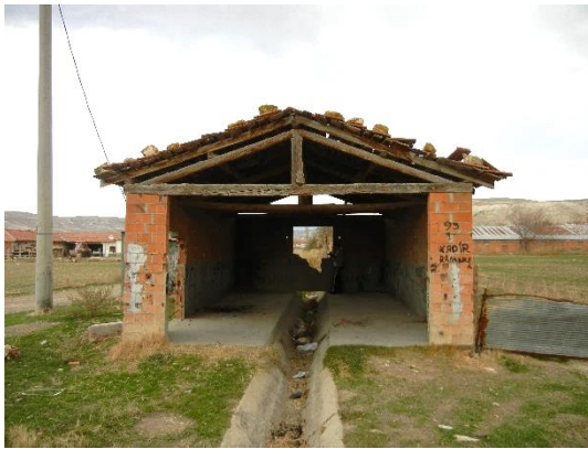
Şekil 4.2. Duvarlarında ocak bulunmayan Bozan Köyü sakanası.
