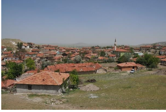
Şekil 3.20. Örencik Köyü'nün merkez mahallesi, 2010.
