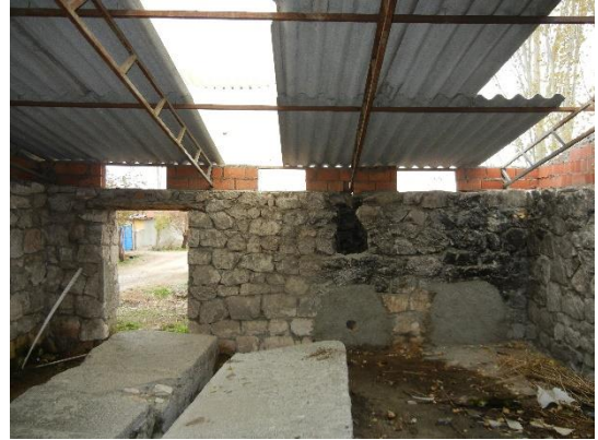
Şekil 3.66. Gündüzler Köyü-2 sakanasında demir profil çatı makasları ve ışıklıkları.
