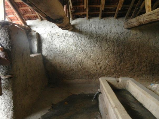
Şekil 3.63. Kızılcaören Köyü sakanasında yalaktaki suyun zemine serbestçe akması.
