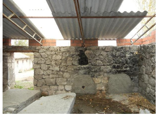
Şekil 4.18. Ocakları birbirine dik iki duvar üzerinde yer alan Gündüzler Köyü-2 sakanasında kapatılmış iki ocak.
