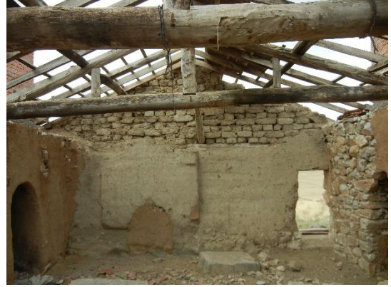
Şekil 4.20. Ocakları üç duvar üzerinde yer alan Karageyikli Köyü sakanasının kapatılmış ocağı.
