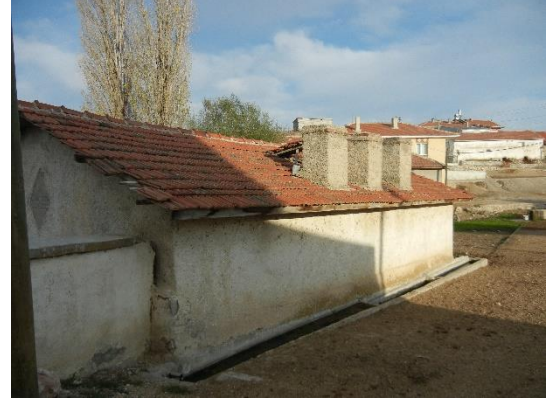
Şekil 4.40. Yörük Karacaören Köyü sakanasının çeşmesi ve cephesine yapışık su yalağı.
