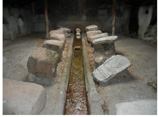
Şekil 3.64. Yakakayı Köyü sakanasının zemininde yer alan su kanalı.
