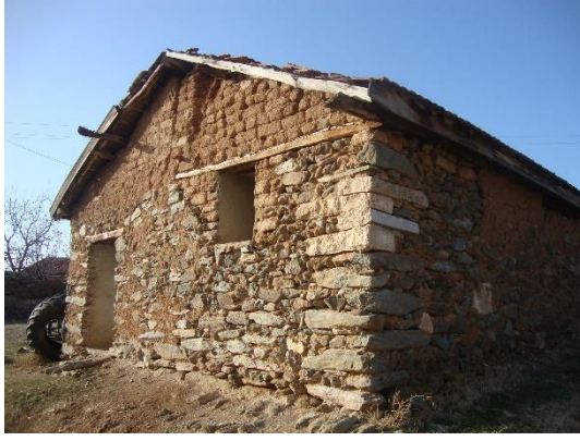
Şekil 3.53. Korucu Köyü-2 sakanası.
