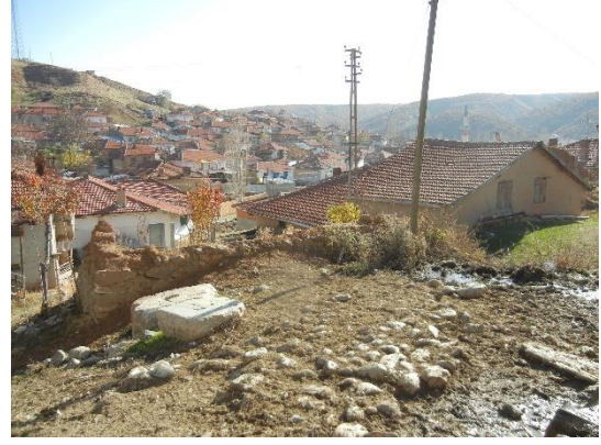
Şekil 3.19. Kayı Köyü'nde yıkılmış durumdaki sakana.
