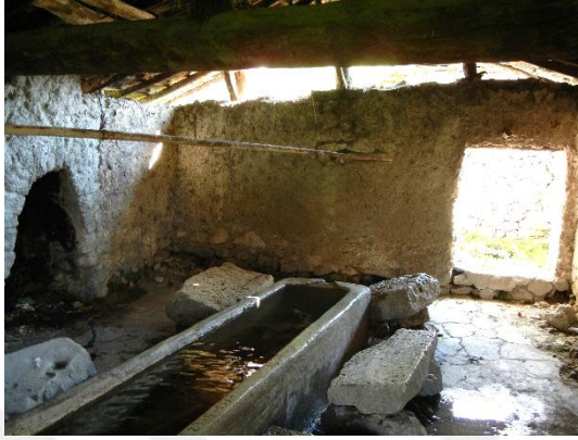
Şekil 3.67. Yukarı Dođanođlu Köyü sakanasının çatı makaslarına asılmış kurutma askısı.
