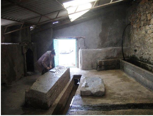
Şekil 3.71. Gündüzler Köyü-1 sakanasındaki beton ve devşirme dövme taşları.
