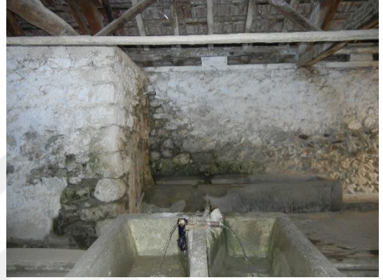
Şekil 4.48. Kayı Köyü-2 sakanasındaki sarniç ve suyun aktarıldığı yalak.
