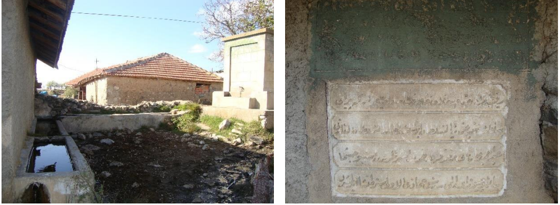
Şekil 3.57. Sakana su sağlayan çeşme ve Şekil 3.58. Sakananın duvarına gömülü kitabesi. yalıklar.
