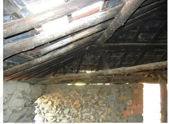
Şekil 4.5. Kızılbörüklü Köyü-2 sakanasında dumanı tahliye etmek için çatı örtüsünde açılmış boşluklar.
