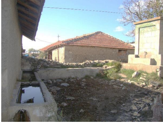
Şekil 4.23. Dağcı Köyü sakanasının cephesine yapışık su yalağı ve çeşmesi.
