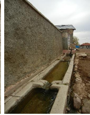
Şekil 4.33. Kızılcaören Köyü sakanasının su yalağının hazneleri.
