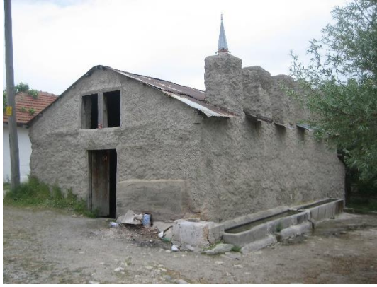
Şekil 4.41. Yukarı İğdeağacı Köyü-1 sakanasının cephesine yapışık su yalağı.
