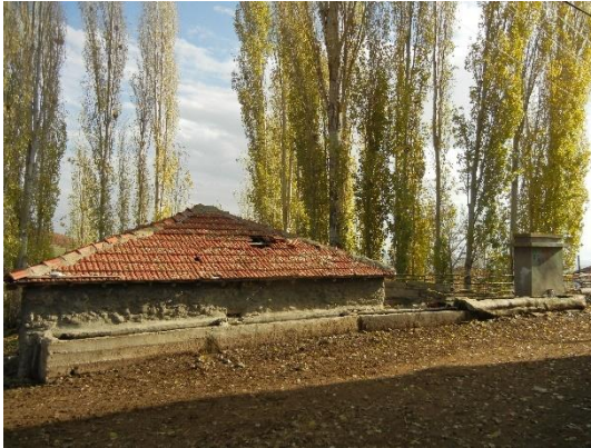
Şekil 3.49. Kızılborüklü Köyü-1 sakanası, çeşme ve yalak.
