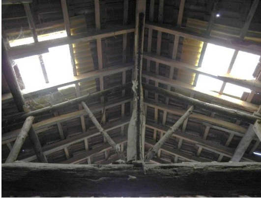
Şekil 3.65. Kızılcaören Köyü sakanasının çatı makası ve ışıklıkları.
