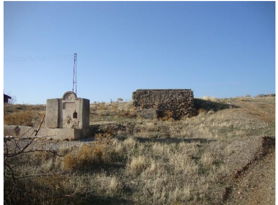
Şekil 4.52. Korucu Köyü-2 sakanasının su deposu ve çeşmesi.
