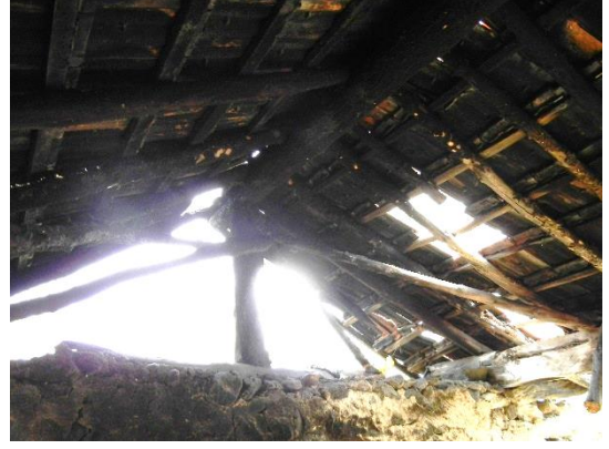
Şekil 4.7. Kızılborüklü Köyü-2 sakanasında ocak olmadığı için yakılan ateşten etkilenen çatı.
