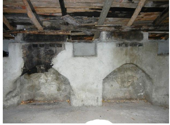
Şekil 3.60. Yakakayı Köyü sakanasının beden duvarı içinde yer alan ocakları ve duvar nişleri.
