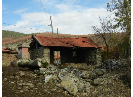
Şekil 3.50. Kızılborüklü Köyü-2 sakanası, çeşme ve yalak.
