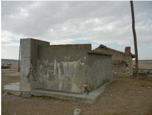
Şekil 4.51. Karageyikli Köyü sakanasının çeşmesi ve su deposu.
