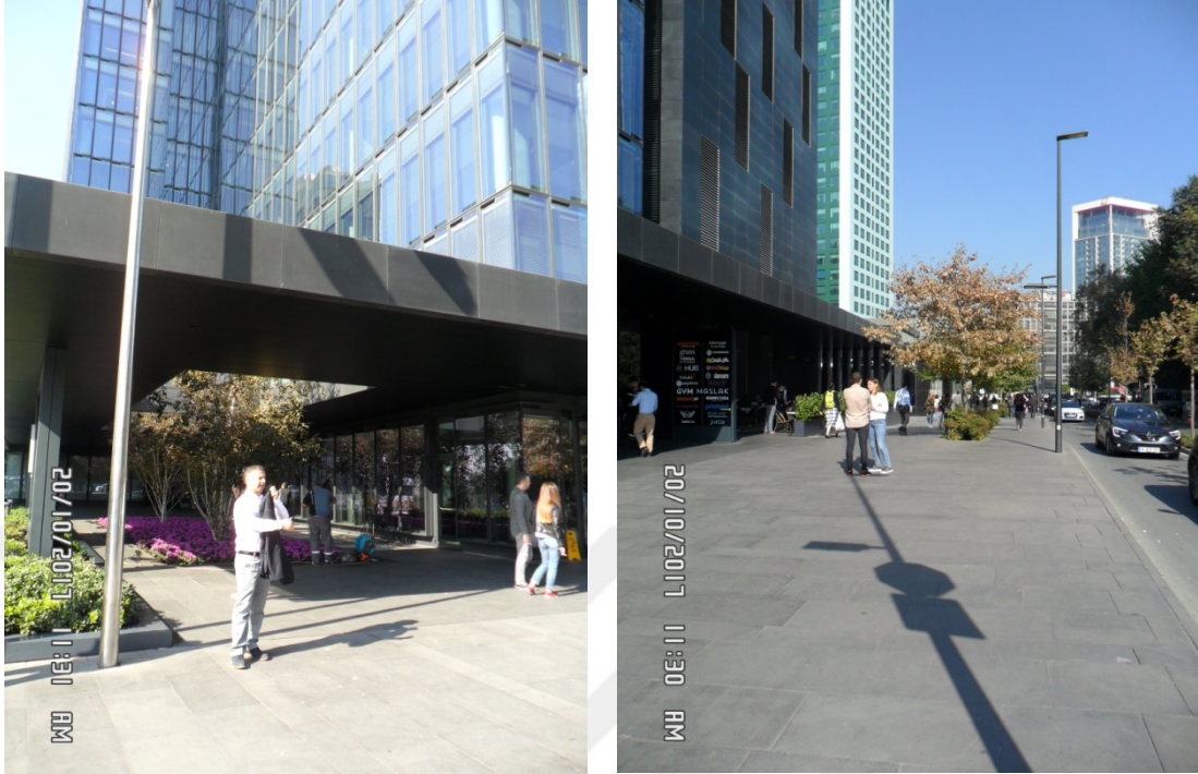
Şekil 4.25: Sağda giriş lobisi önündeki küçük avlu, solda kaldırım genişletmesi.
