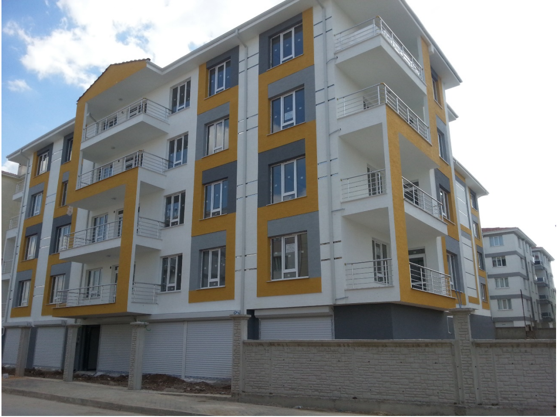
Görsel 5.8. BN08 kodlu binanın genel görünüşü
