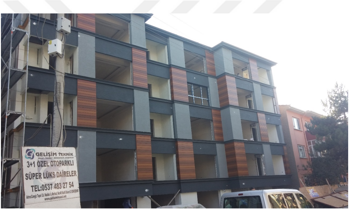
Görsel 5.17. BN17 kodlu binanın genel görünüşü
