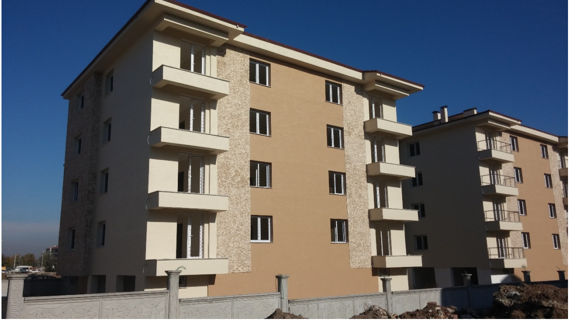
Görsel 5.18. BN18 kodlu binanın genel görünüşü
