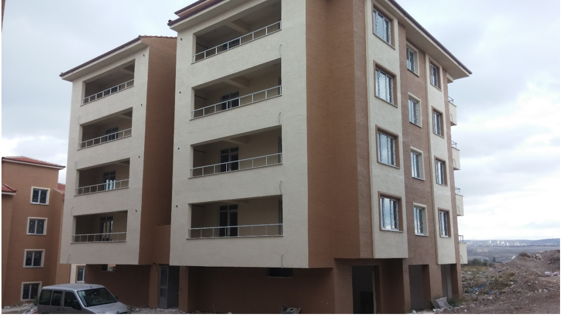
Görsel 5.16 BN16 kodlu binanın genel görünüşü
