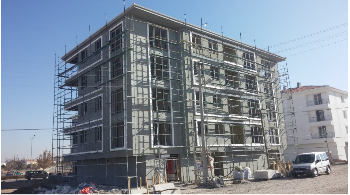
Görsel 5.24. BN24 kodlu binanın genel görünüşü
