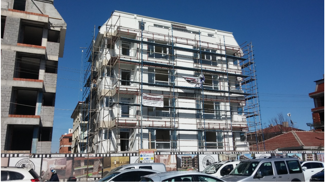
Görsel 5.6. BN06 kodlu binanın genel görünüşü
