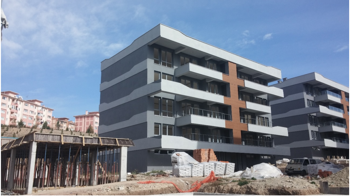
Görsel 5.20. BN20 kodlu binanın genel görünüşü
