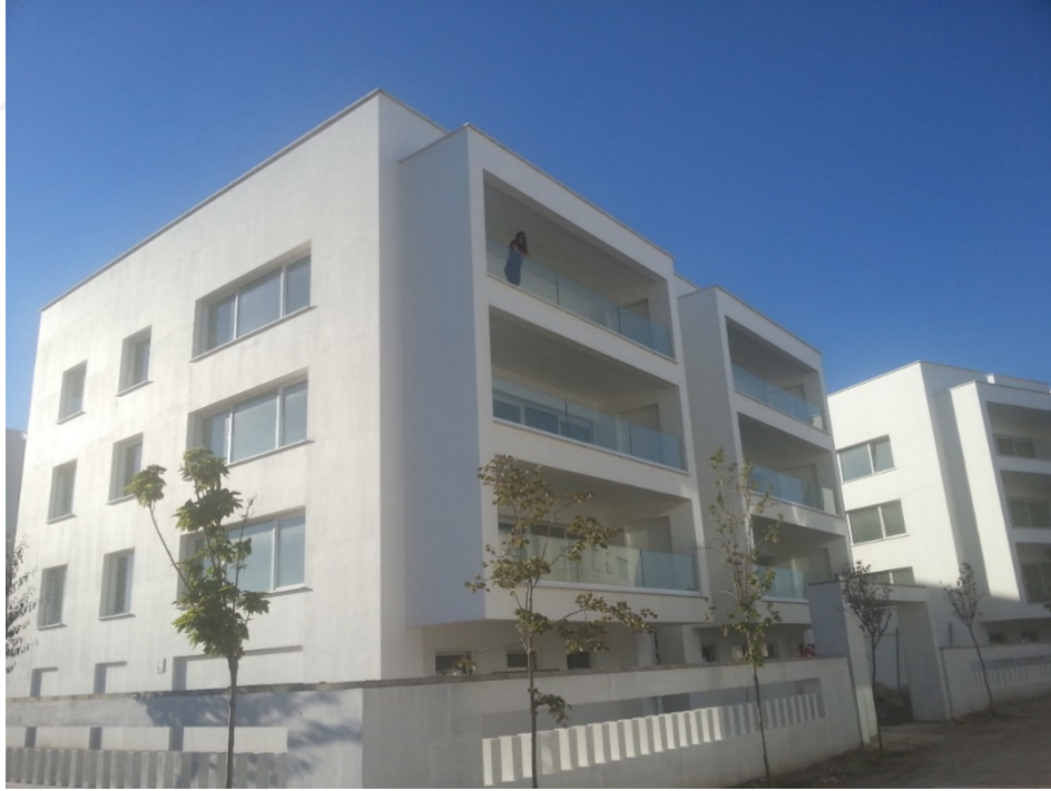
Görsel 5.1. BN01 kodlu binanın genel görünüşü
