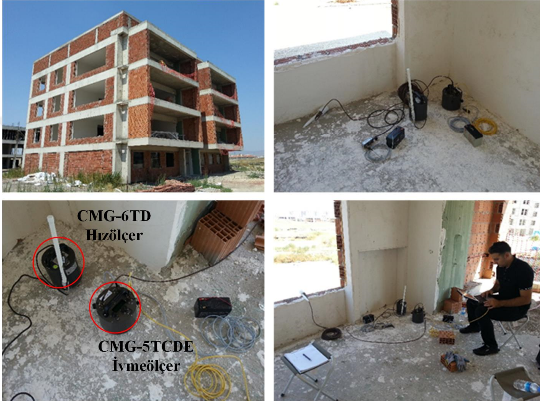
Görsel 4.11. BN01 kodlu binanın duvarları örülü iken CMG-5TCDE ivmeölçerler ve CMG-6TD hızölçerler ile çevresel titreşim ölçümü
