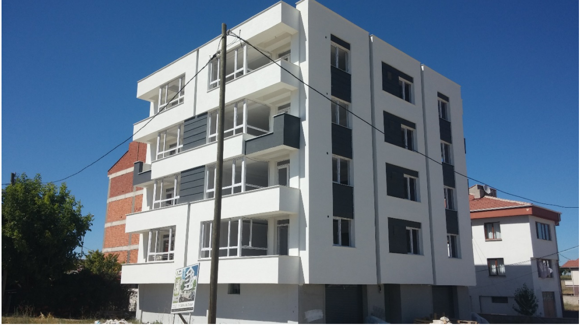
Görsel 5.3. BN03 kodlu binanın genel görünüşü
