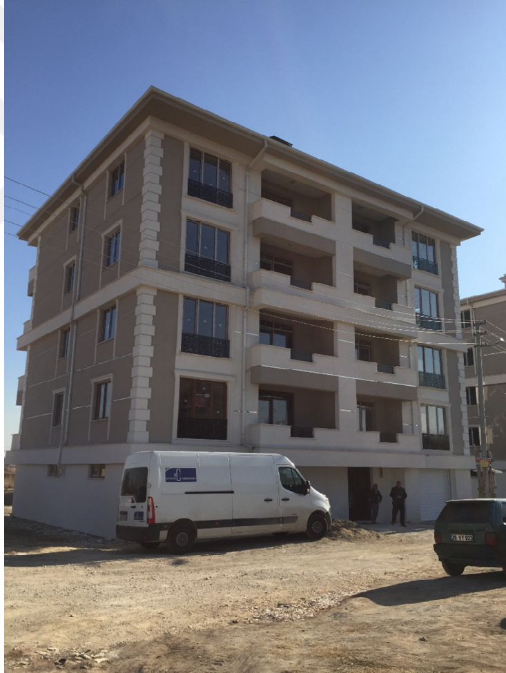
Görsel 5.23. BN23 kodlu binanın genel görünüşü
