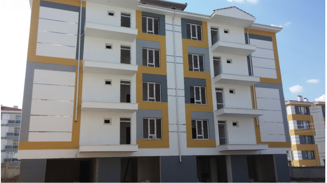
Görsel 5.10. BN10 kodlu binanın genel görünüşü
