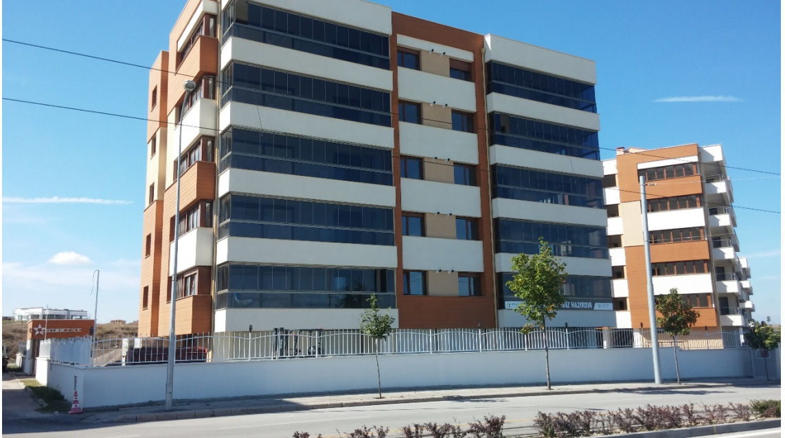
Görsel 5.13. BN13 kodlu binanın genel görünüşü
