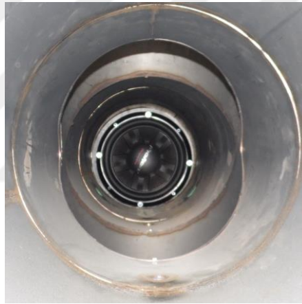
Şekil 3. 13. Hoparlörün yanma odası içerisinden görünüşü.
