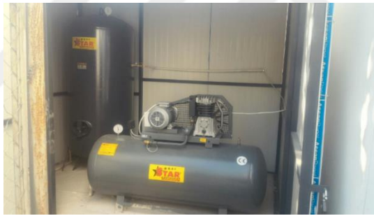
Şekil 3. 20. Kompresör, harici hava tankı, kompresör muhafazası için oluşturulmuş yapı.
