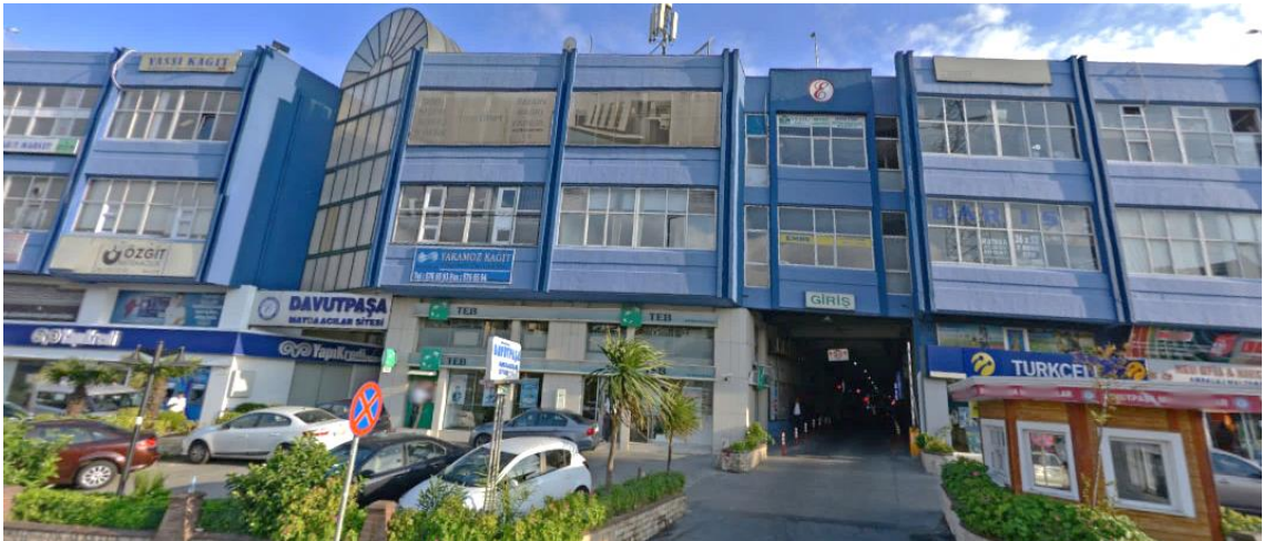
Şekil 5.8 Dokuma Atölyesi'nin yer aldığı sanayi yapısı
