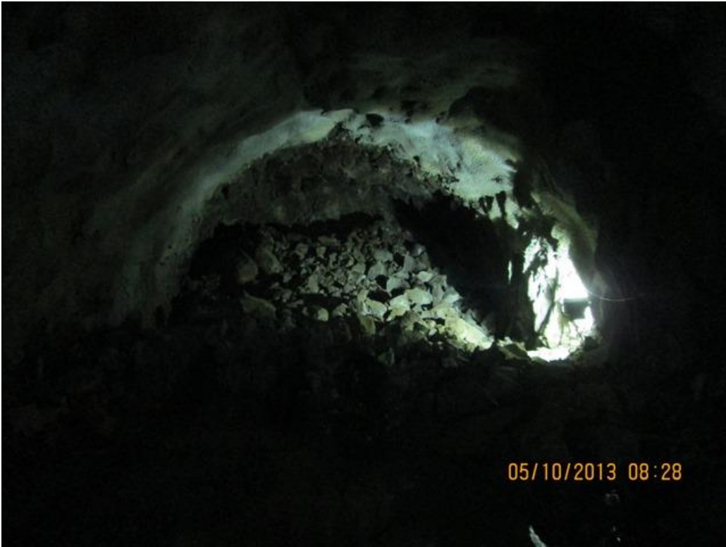
Şekil 3.20. Derivasyon tüneli patlatma sonrası malzeme görünümü
