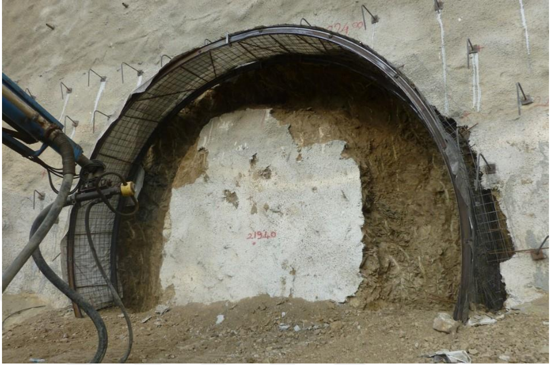
Şekil 5.3. Derivasyon tüneli çıkış portal kemerlenmeyi sağlama çalışmaları
