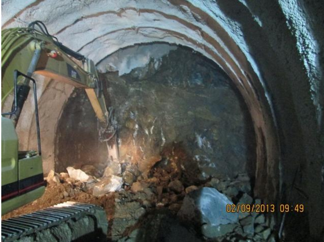
Şekil 3.18. Derivasyon tüneli mekanik kazı çalışması
