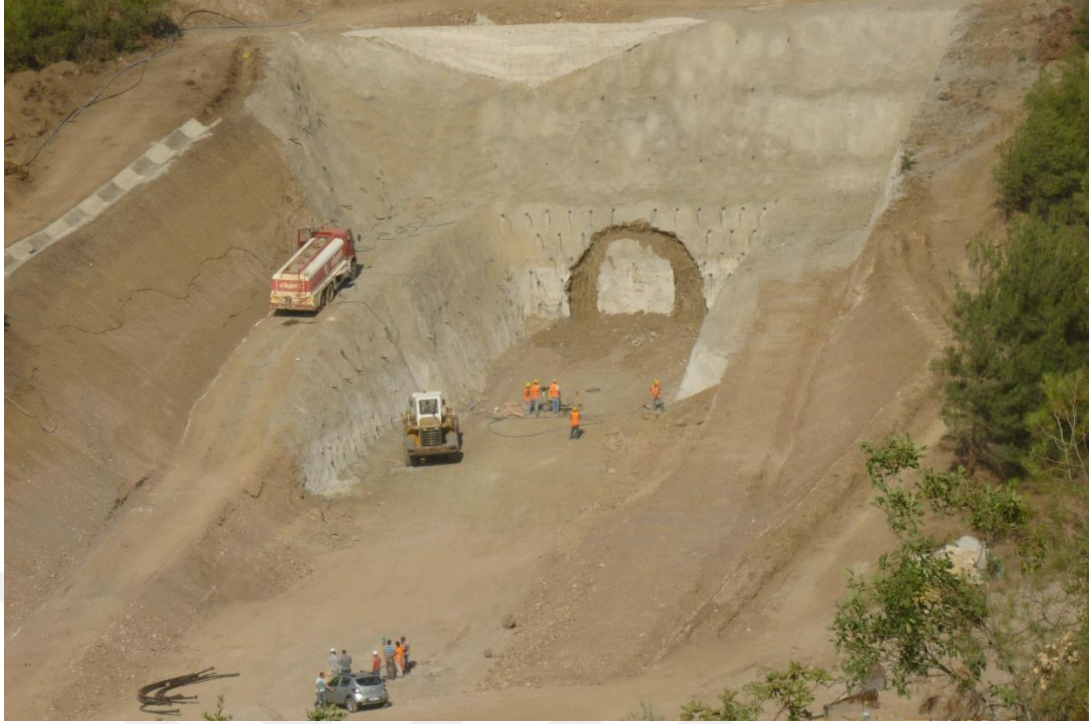
Şekil 5.1. Derivasyon tüneli çıkış ağzı kazı çalışmaları
