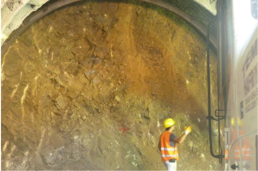
Şekil 5.5. Derivasyon tüneli kazı aşamasında karşılaşılan zayıflık düzlemleri
