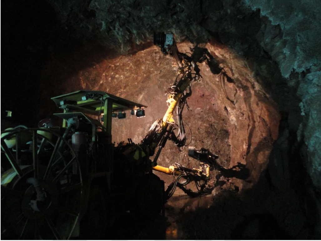
Şekil 3.19. Derivasyon tüneli patlatma için delgi çalışması
