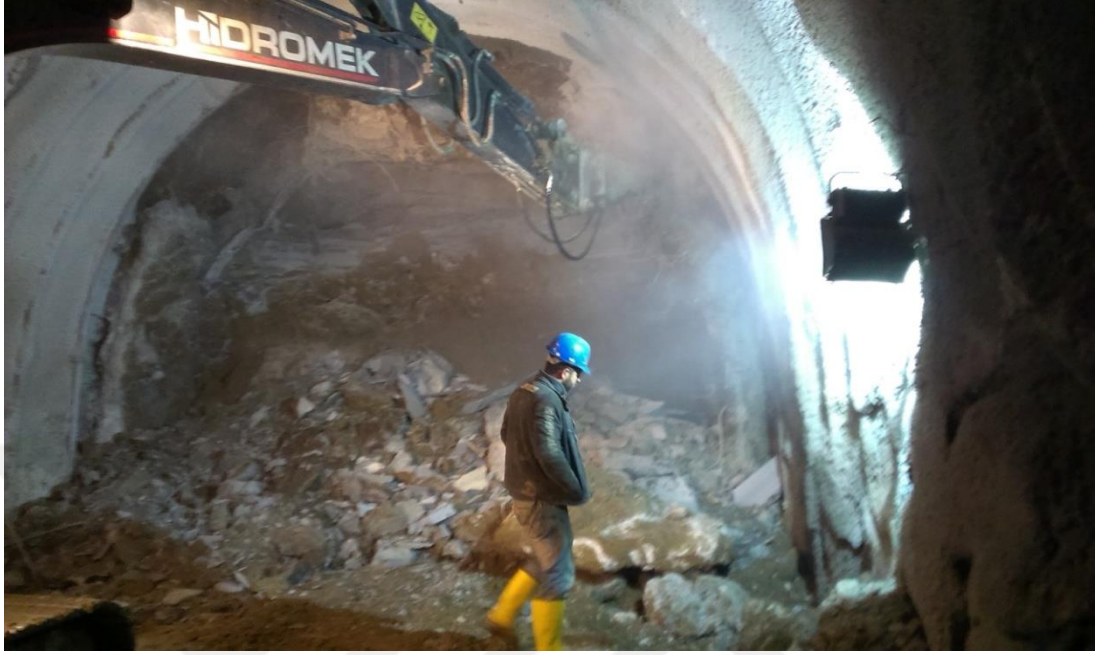
Şekil 5.15. Deformasyon bölgesinde tekrar kazıya başlanması
