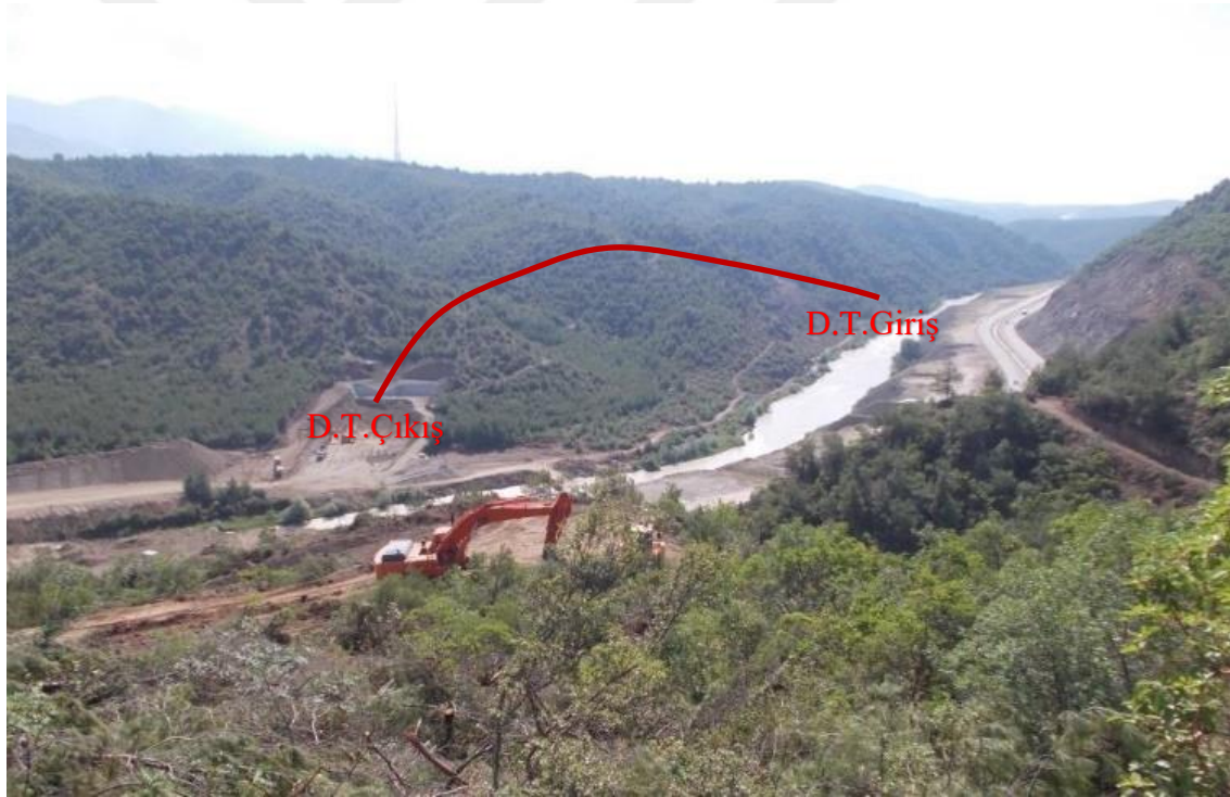
Şekil 3.5. Derivasyon tüneli güzergah mostra görünümü
