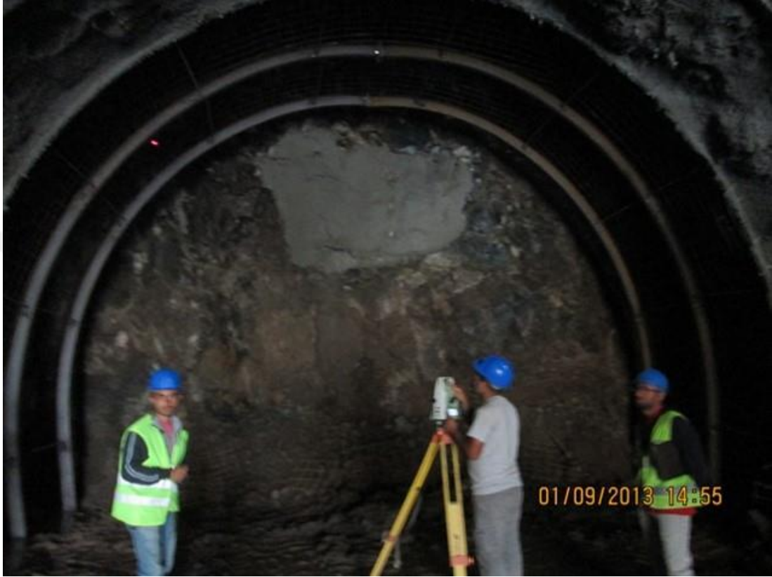
Şekil 5.8. Total station ile derivasyon tüneline deformasyon okuması
