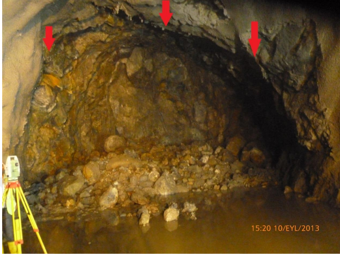
Şekil 5.9. Derivasyon tüneli deformasyon ölçüm noktaları
