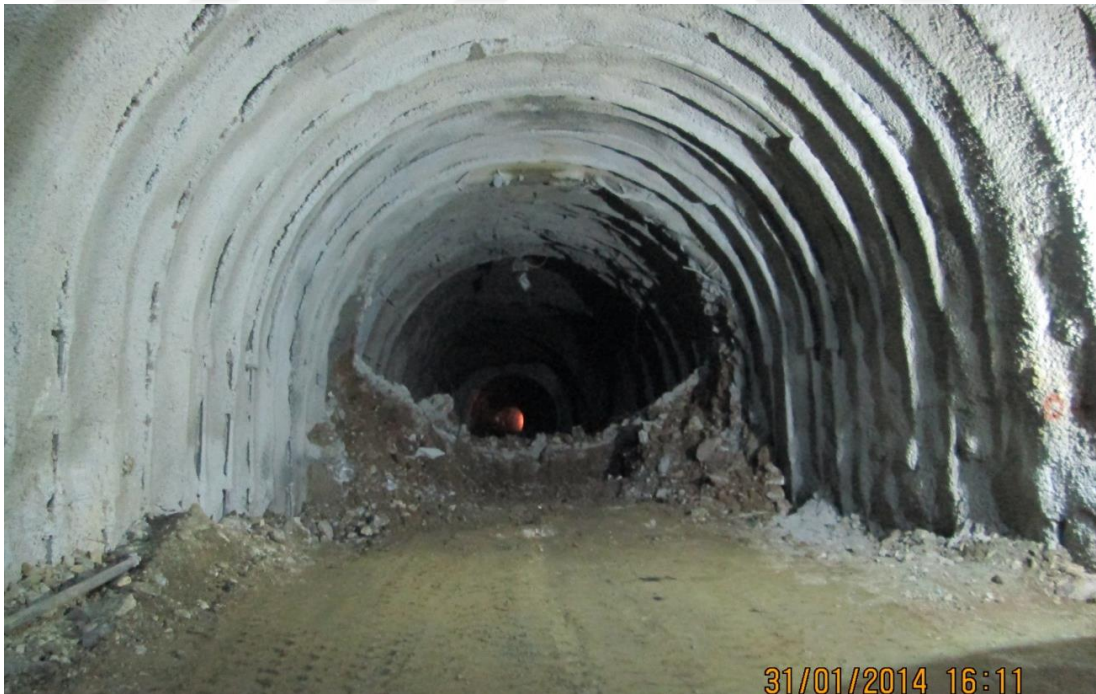
Şekil 5.18. Derivasyon tüneline tamamen açılması
