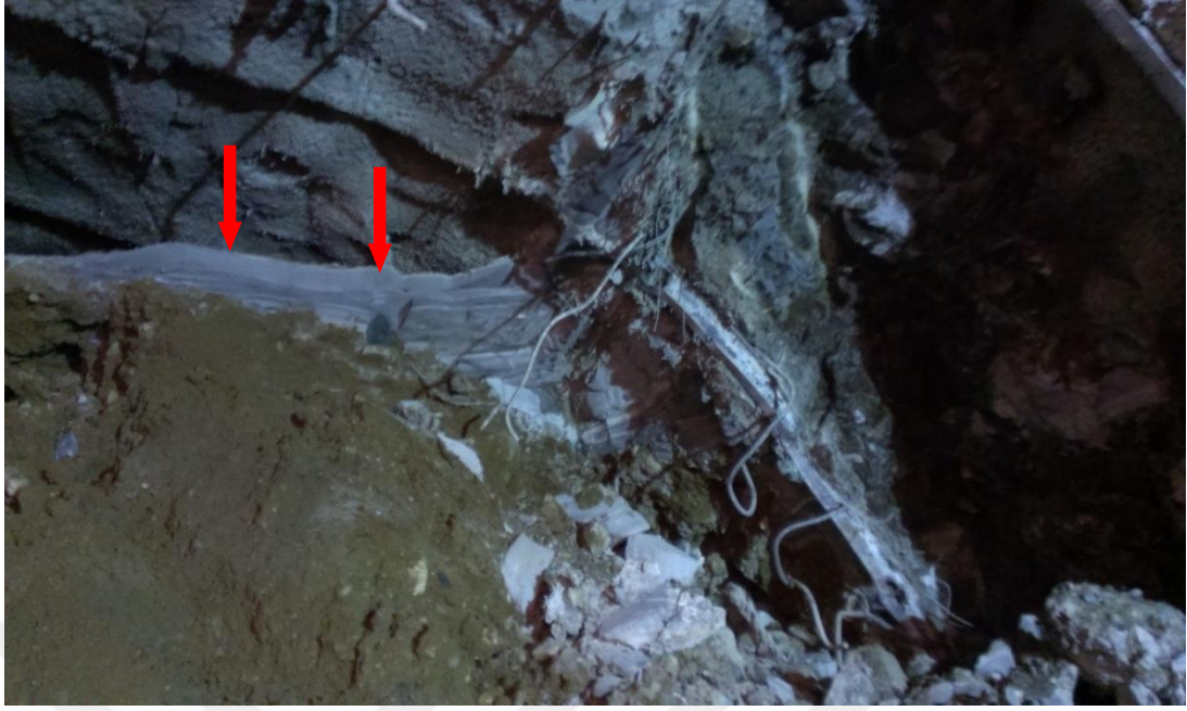
Şekil 5.13. Deformasyon bölgesine yapılan enjeksiyon tabakası
