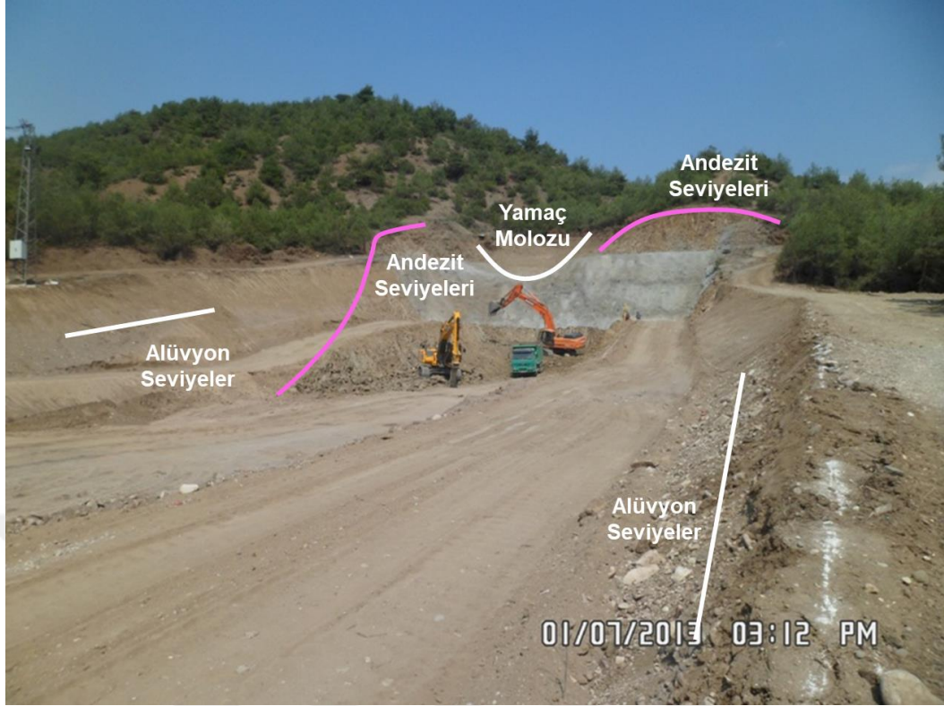
Şekil 3.6. Derivasyon tüneli çıkışında gözlenen birimler
