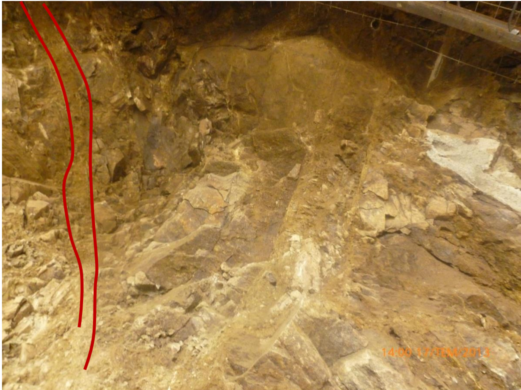
Şekil 3.9. Seyfe formasyonuna ait tünel aynasında gözlenen killeşme zonları
