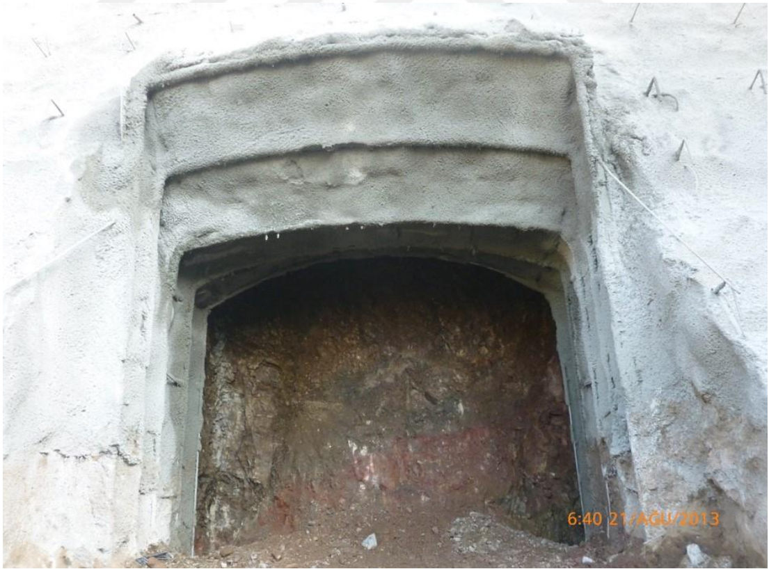
Şekil 5.4. Derivasyon tüneli giriş portal kemerlenmeyi sağlama çalışmaları
