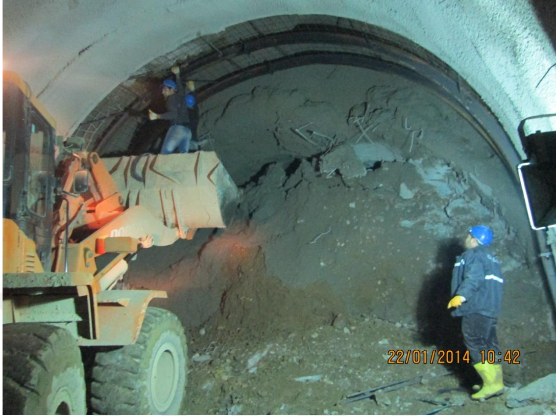
Şekil 5.17. Deformasyon bölgesinin yeniden desteklenmesi
