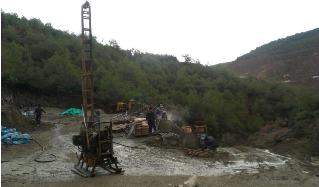
Şekil 5.14. Açık sahadan deformasyon bölgesine iyileştirme çalışmaları
