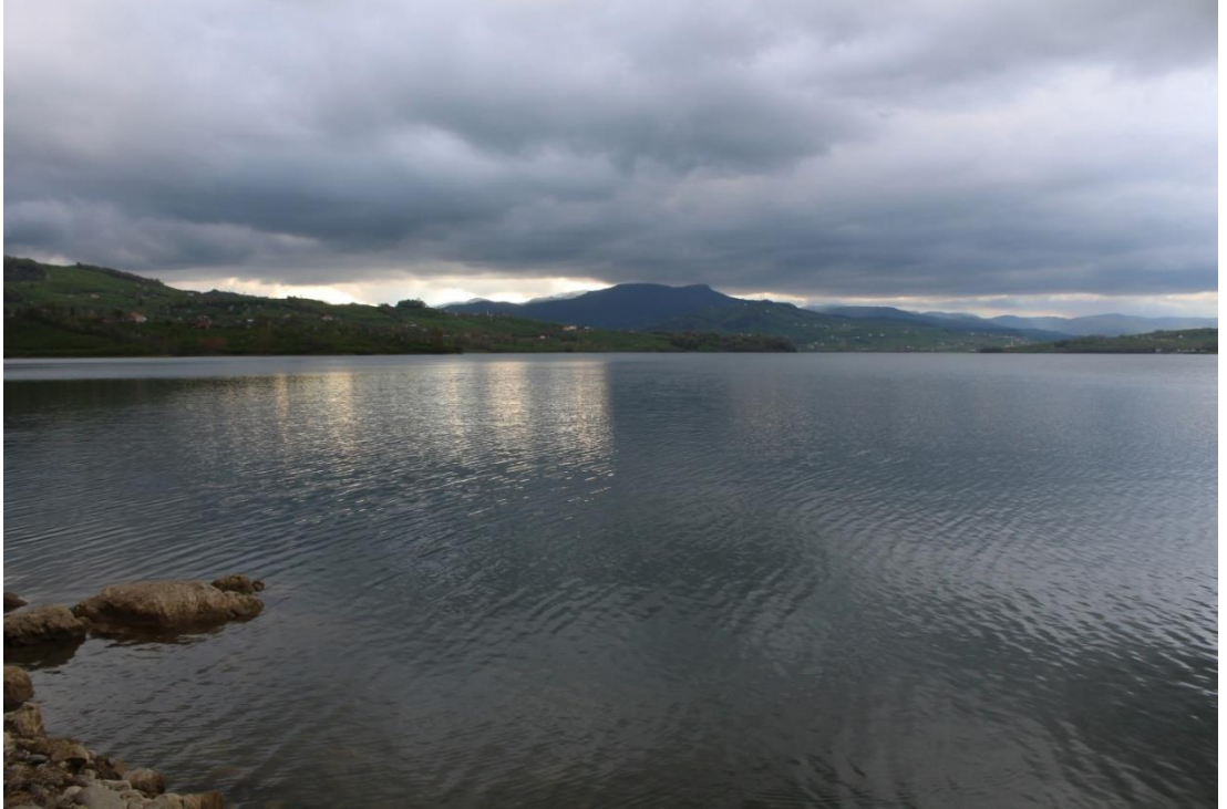
Şekil 49: Çakmak Baraj Gölünden bir görünüm, güneybatıya bakış.
