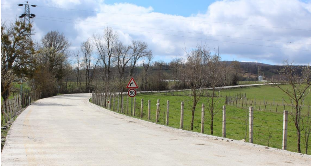
Şekil 40: İnceleme alanındaki beton kaplama köy yollarına bir örnek, Yeniömerli köyü.
