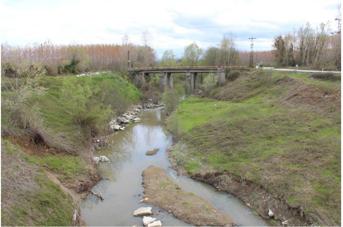
Şekil 73: Dikbıyık köyünde Abdal Çayı vadisine bırakılan molozlar.
