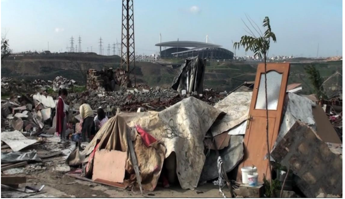
Resim 57. Ayazma’da Yıkım ve Dönüşüm
