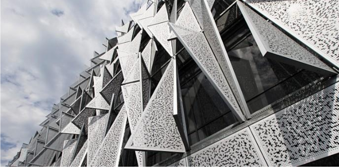
Şekil 38 : SDU Campus Kolding Binası hareketli perforé metal panel detayı (Url-14).
