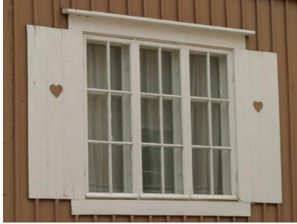
Şekil 2.1: İsveçrenin eski çiftlik evlerinde çift cidar pencere. (Alessi, 2008)
