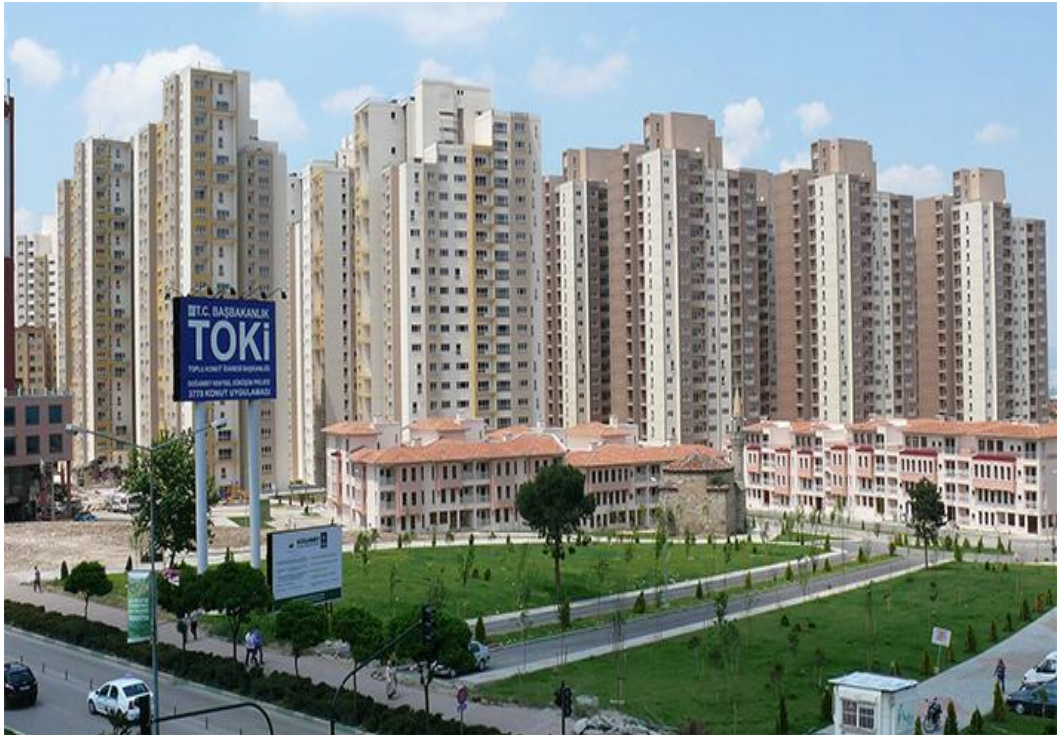
Şekil 5.26 : Dönüşüm projesi genel görünüm (Url – 35).
