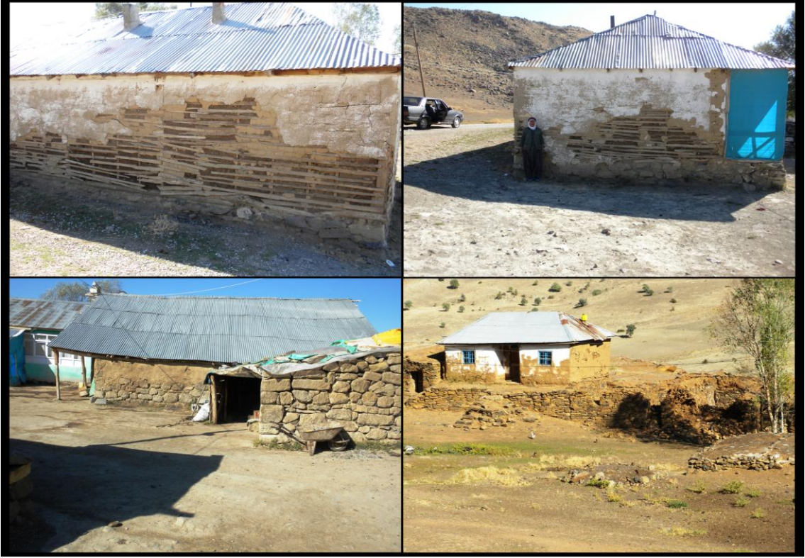
Foto 39. 1966 Varto depreminden sonra yöre halkının inşa ettiği ve bir kısmı halen kullanılan eski deprem konutları
