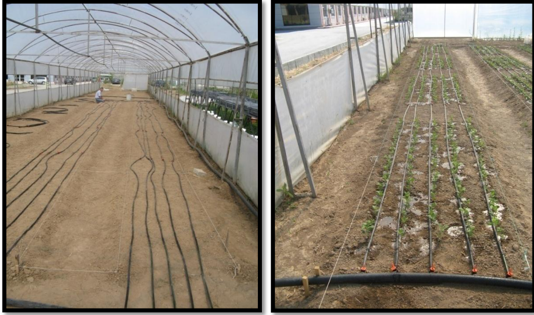
Şekil 3.7. Sulama sistemlerinin kurulumu ve sulama suyunun parsellere uygulanması
