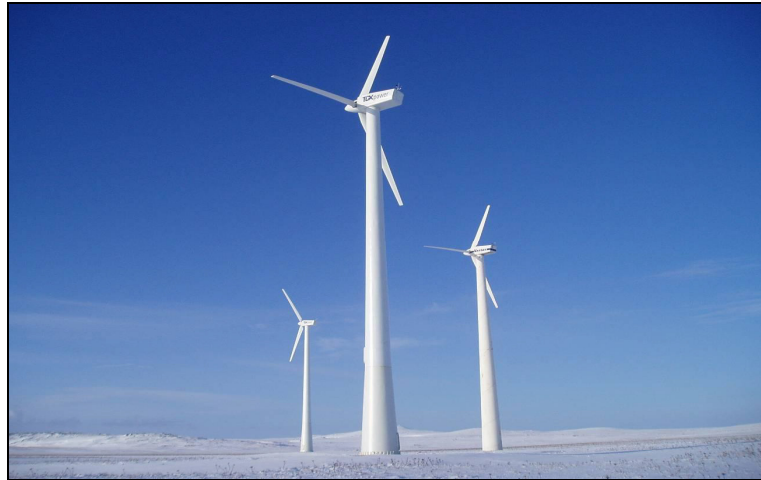
Şekil 3.17. Kule yüksekliği atıkça enerji de artar
