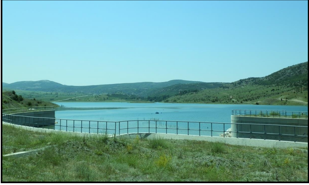
Foto 29 : Hatap Barajı'nın Kuzeyden Görünümü
