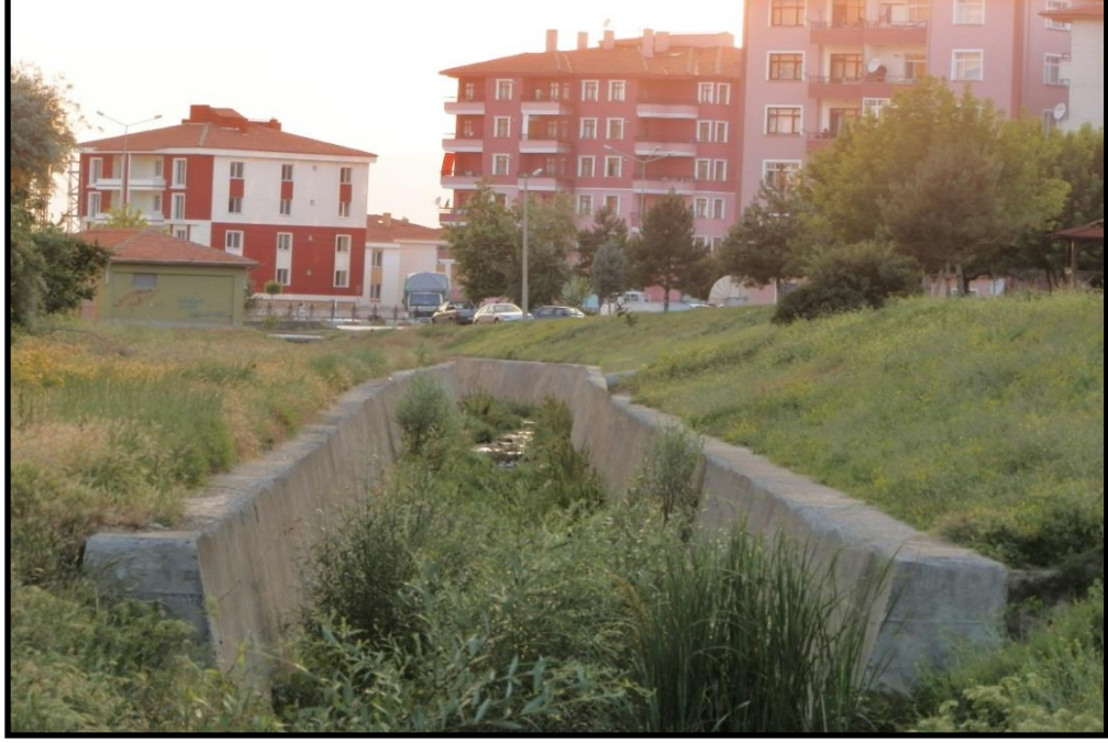
Foto 39 : Çorum Merkez Gülabibey Mahallesi Taşkın Koruma ve Erozyon Rüşubat Kontrol Yapılarından Bir Görünüm
