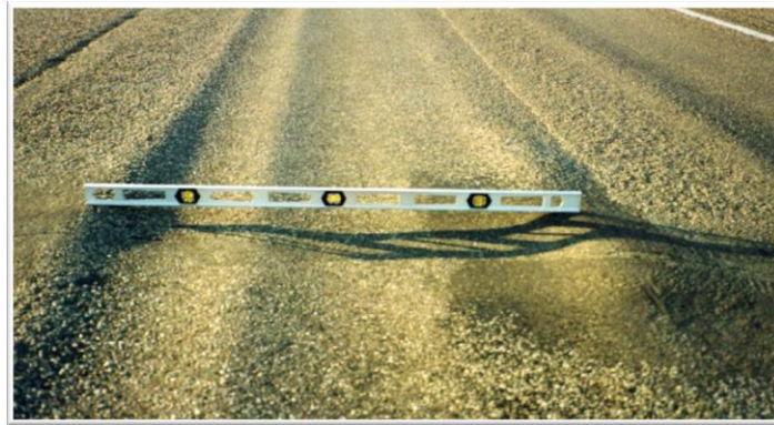
Şekil 2.29. Yüksek şiddette tekerlek izinde oturmalar (İsfalt, 2002).
