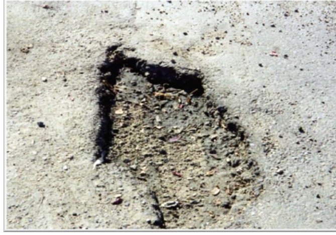
Şekil 2.25. Orta şiddette çukur (İsfalt, 2002).
