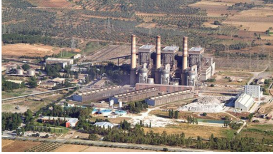
řekil 2.2. Yatađan Termik Santrali
