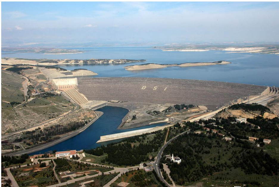
Şekil 2.17 Atatürk Barajı (Dsi, 2012)
