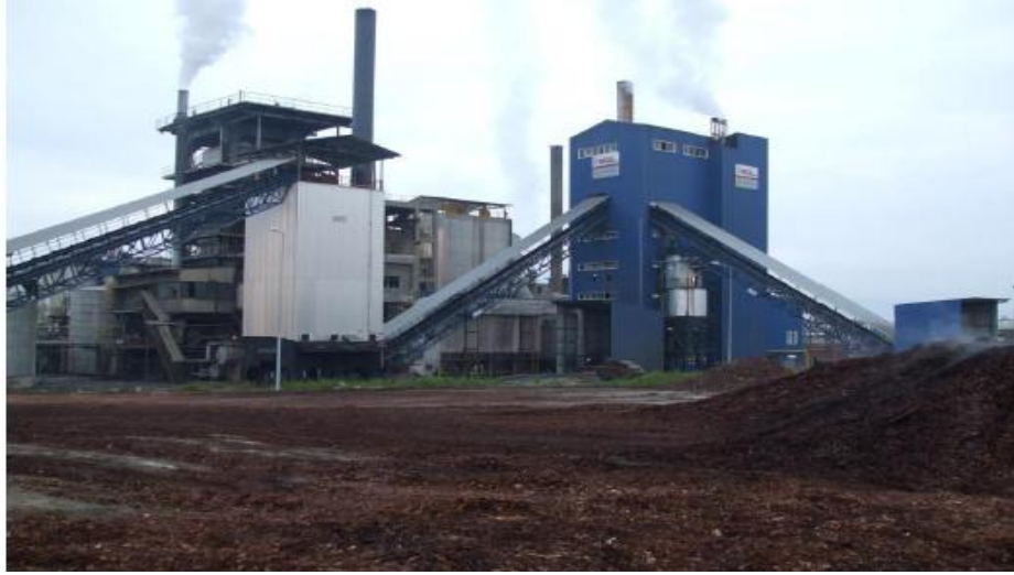
Şekil 2.22 OYKA Çaycuma Kağıt Ambalaj Fabrikası'nın Enerji Tesisi (Ogm, 2010)
