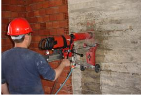
Şekil 3.3. Karot alınması işlemi
