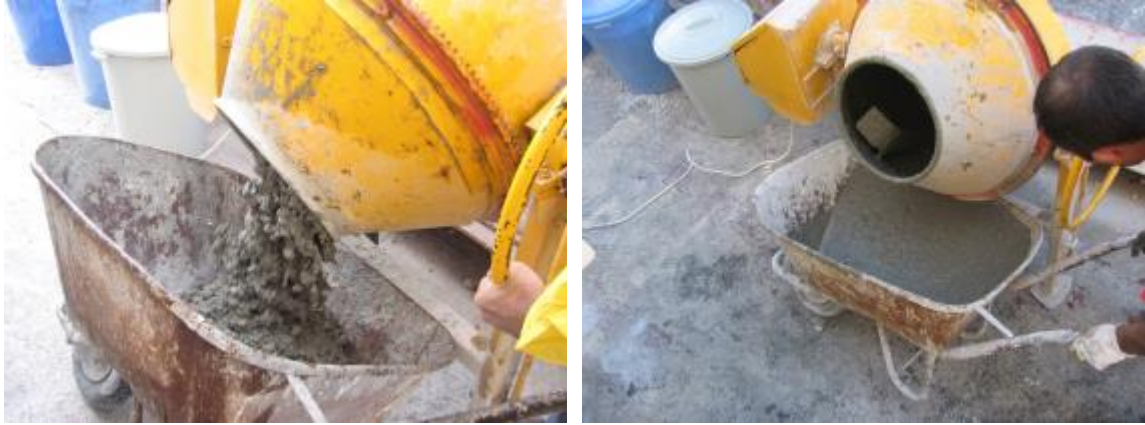
Şekil 6.7. Betonun aktarılması
