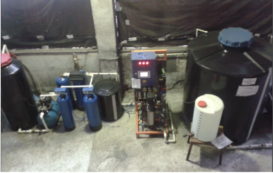
Şekil 3.7. Ters ozmos arıtma sisteminin fiziksel görünüşü.
