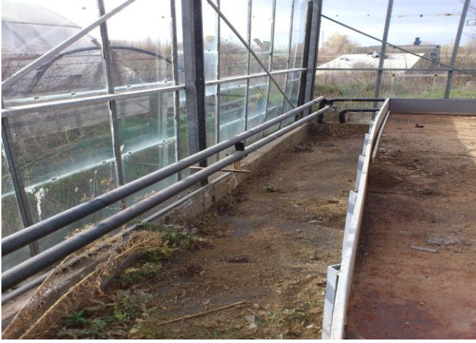
Şekil 3.7. Cam Sera Isıtma Boru Düzeninin Görünümü
