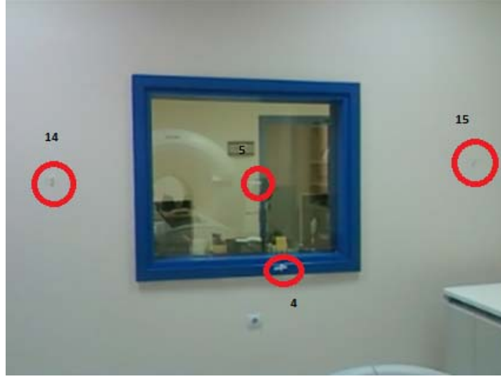
Şekil 3.13. PET tesisinde bulunan operatör odası ve görüntüleme odası arasındaki zırhlı pencere ve duvara dozimetrelerin yerleşimi.
