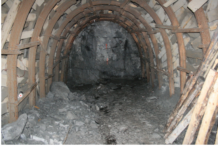
Şekil 9.38 Patlatma öncesi arının durumu ve delik yerleri.
