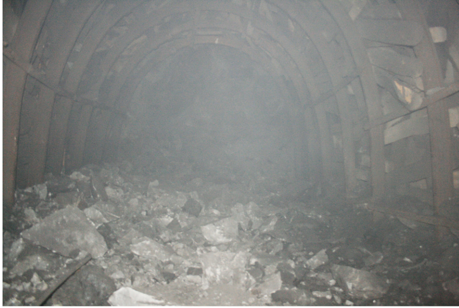
Şekil 9.12 Atımdan yaklaşık 5 dk sonra galeri arınında gözlenen gaz ve toz bulutu (21 Mart 2013 atımı).
