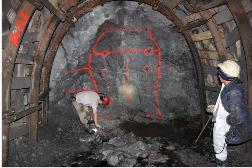
Şekil 9.31 Patlatma öncesi arının durumu ve delik yerleri.
