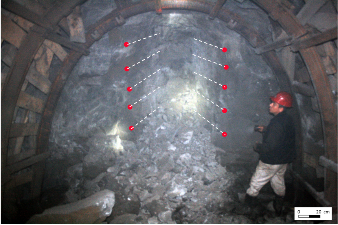
Şekil 7.17 20.05.2013 tarihli atıma ait patlatma sonrası oluşan kazı boşluğunun ve ufalanma bölgesi boyutunun belirlenmesi
