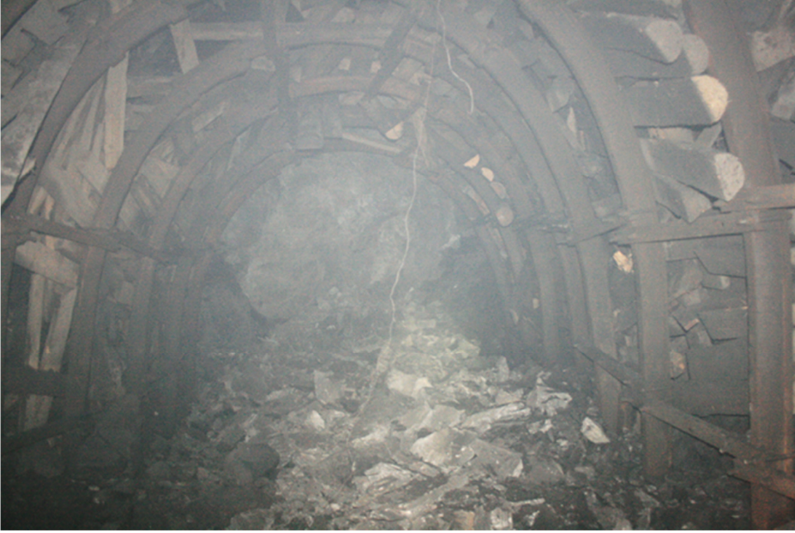
Şekil 9.10 Delik şablonu verilmiş olan 5 Nisan 2013 atımı sonrası galeri arınının görünümü.
