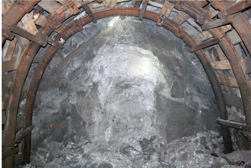
Şekil 9.32 Patlatma sonrası arının durumu.
