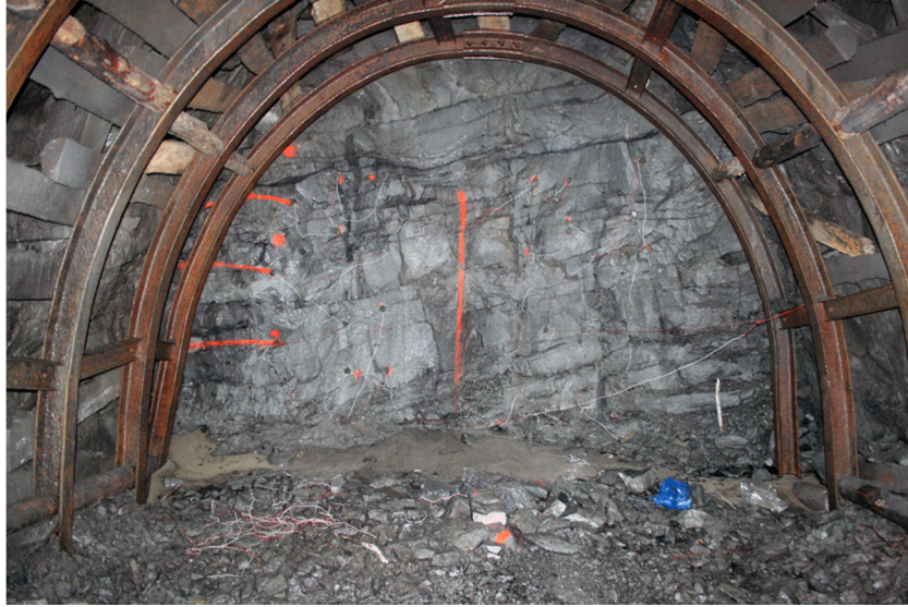
Şekil 9.34 Patlatma öncesi arının durumu ve delik yerleri.
