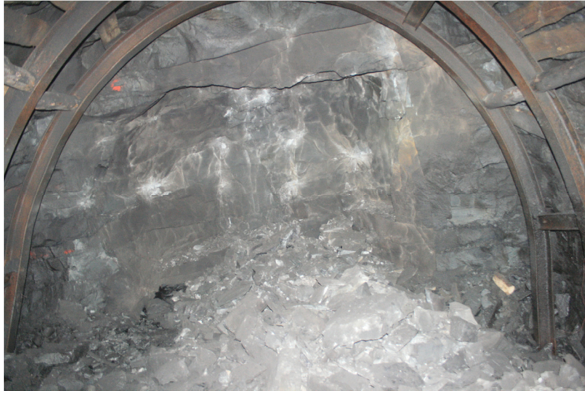
Şekil 9.35 Patlatma sonrası arının durumu.
