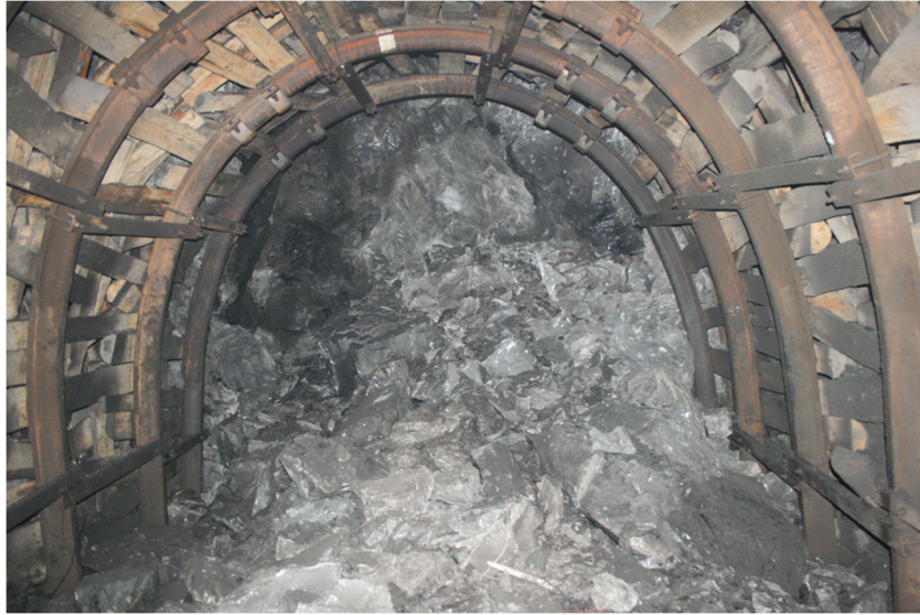
Şekil 9.23 Patlatma sonrası arının durumu.
