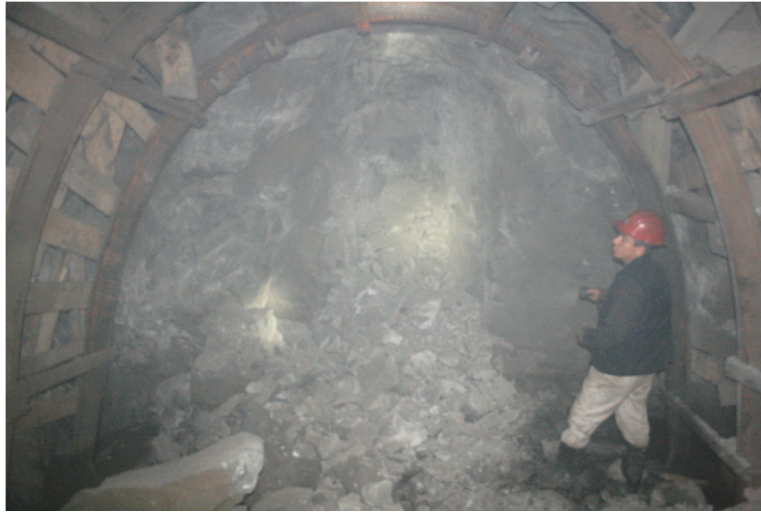
Şekil 9.29 Patlatma sonrası arının durumu.
