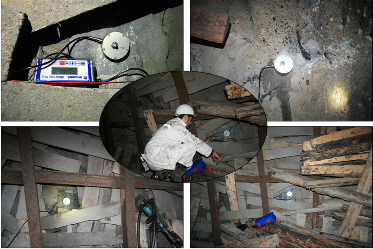
Şekil 6.15 Sarsıntı ölçer cihazın galeri yan duvarına yerleştirilmesi.
