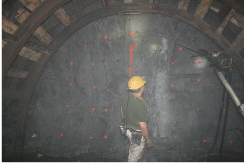
Şekil 9.25 Patlatma öncesi arının durumu ve delik yerleri.
