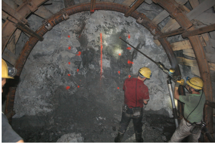
Şekil 9.28 Patlatma öncesi arının durumu ve delik yerleri.
