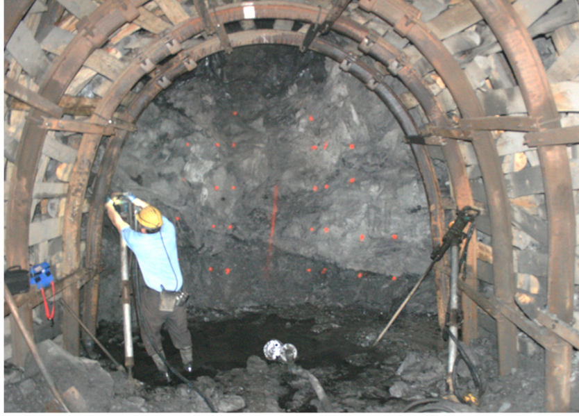
Şekil 9.22 Patlatma öncesi arının durumu ve delik yerleri.
