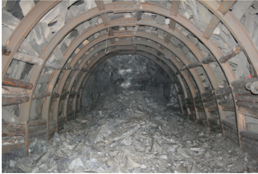
Şekil 9.26 Patlatma sonrası arının durumu.
