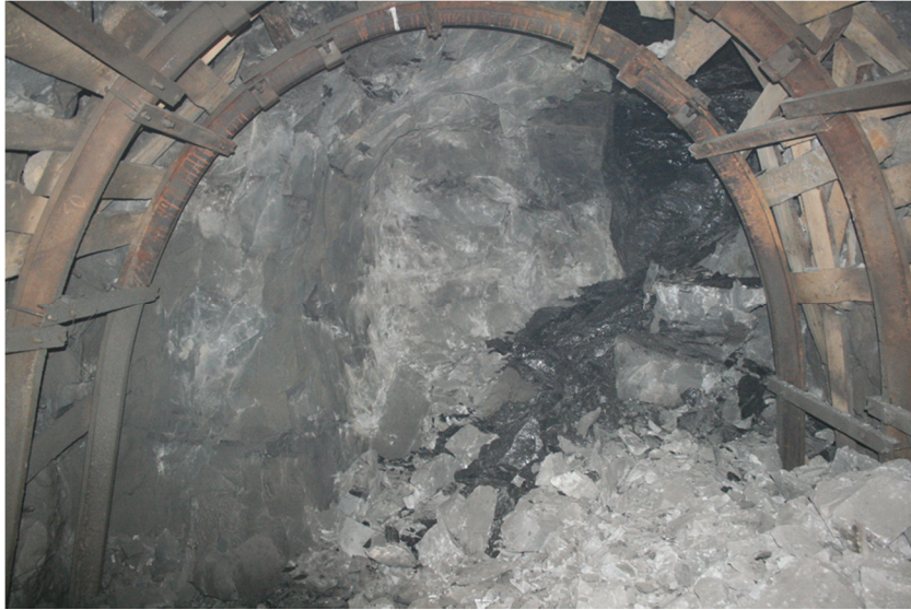
Şekil 9.39 Patlatma sonrası arının durumu.
