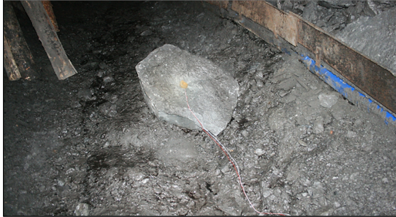
Şekil 9.11 Patlatma sonrası oluşan büyük kaya parçalarının patlatılması (patar atımı).
