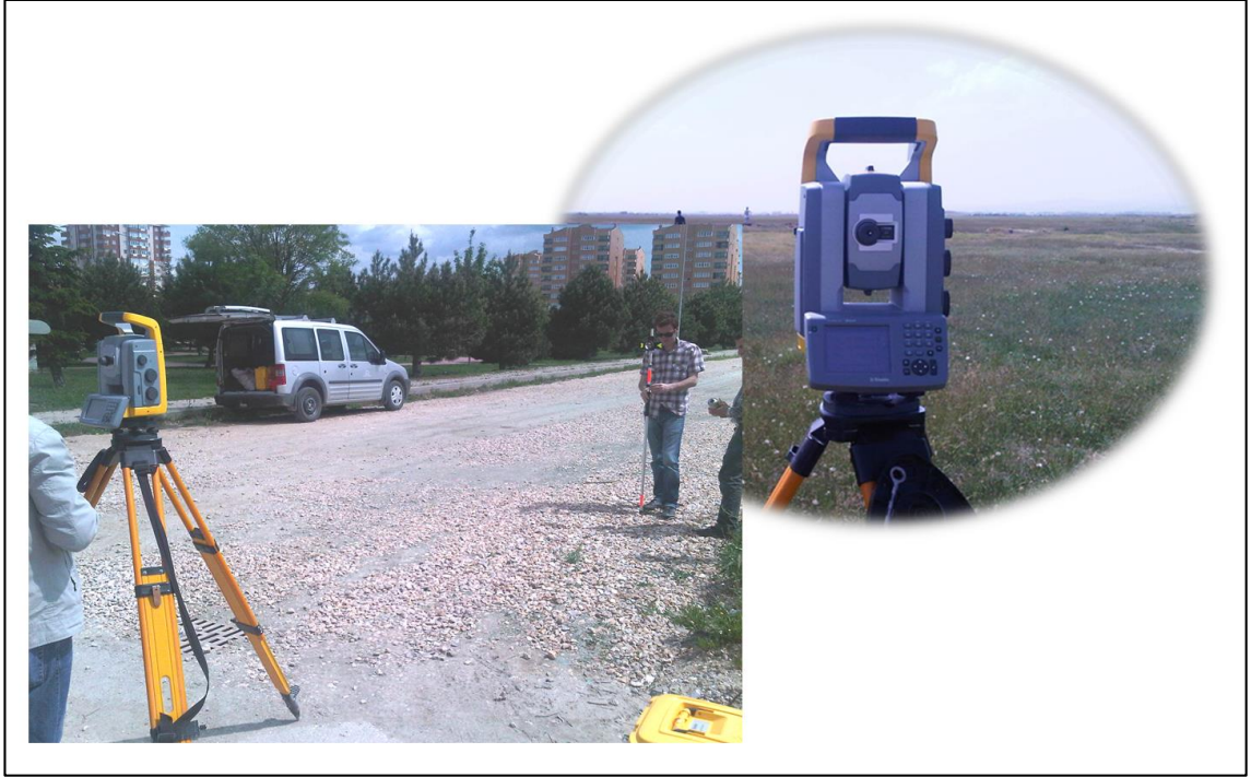
Şekil 3. 7: Çalışmada kullanılan Total station ve uygulamadan bir fotoğraf.
