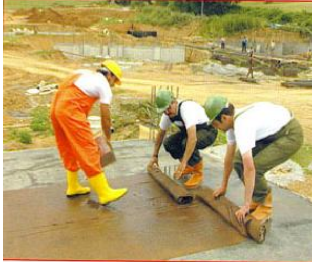
Şekil 4.23 : Betonun bakımın yapılması [40].
