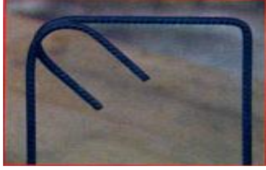
Şekil 4.10 : Özel deprem etriyelerinin 135° kıvrımlı kancası.
