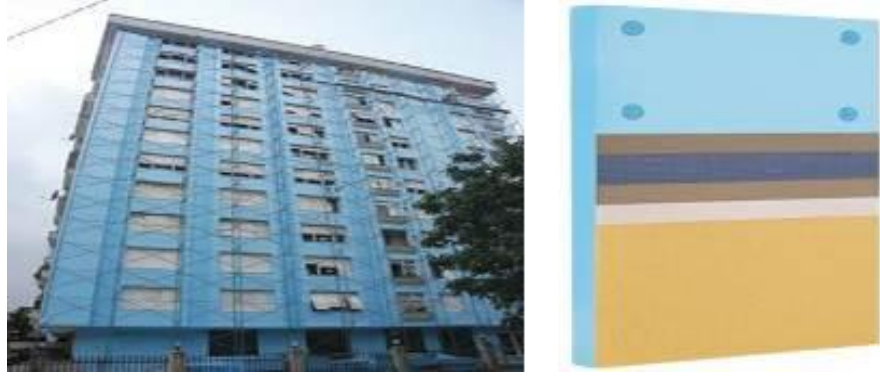
Şekil 4.37 : Dıştan yapılan ısı yalıtımı uygulaması (Mantolama) [72].
