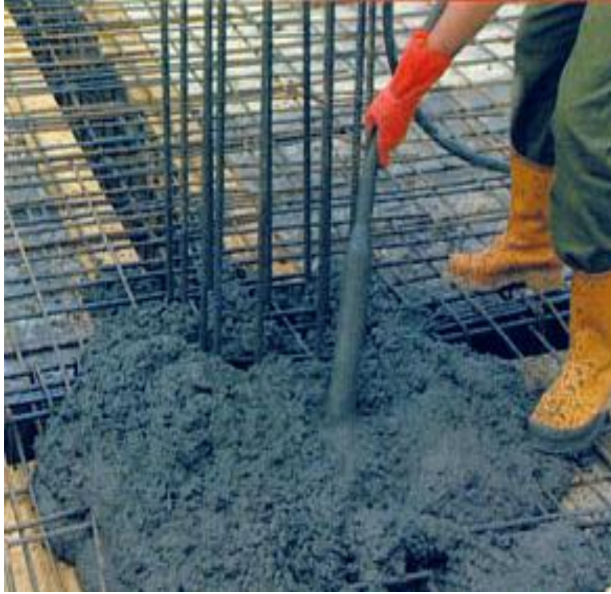
Şekil 4.17 : Betonun Vibratör ile sıkıřtırılması.
