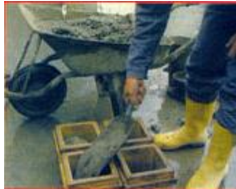
Şekil 4.19 : Şantiyede beton küp numunelerinin alınması [40].
