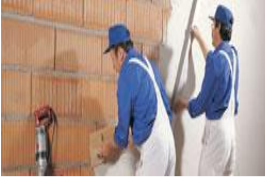
Şekil 4.48 : Alçı sıva uygulaması [93].
