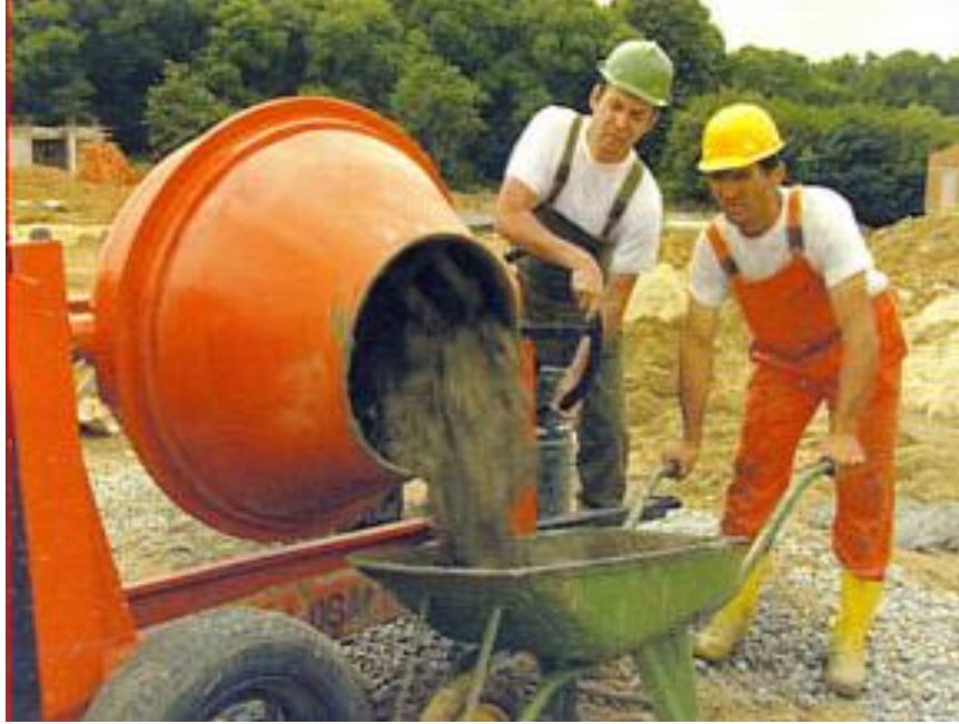
Şekil 4.14 : Küçük inşaatlarda kullanılabilecek Betonyer [40].
