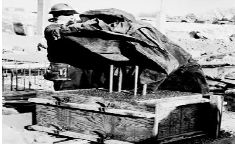
Şekil 4.21 : Bir temel ayağının plastik örtü ile korunması [44].
