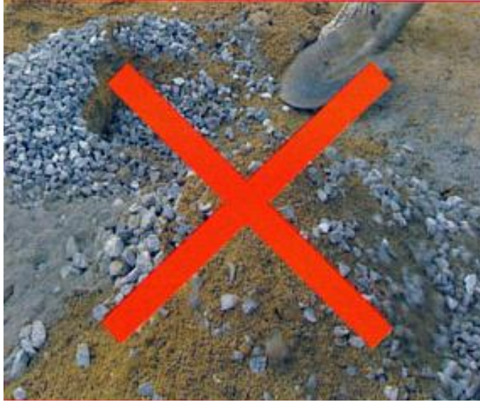
Şekil 4.13 : Kürekle Karıştırılarak Beton Yapılmaz [40].
