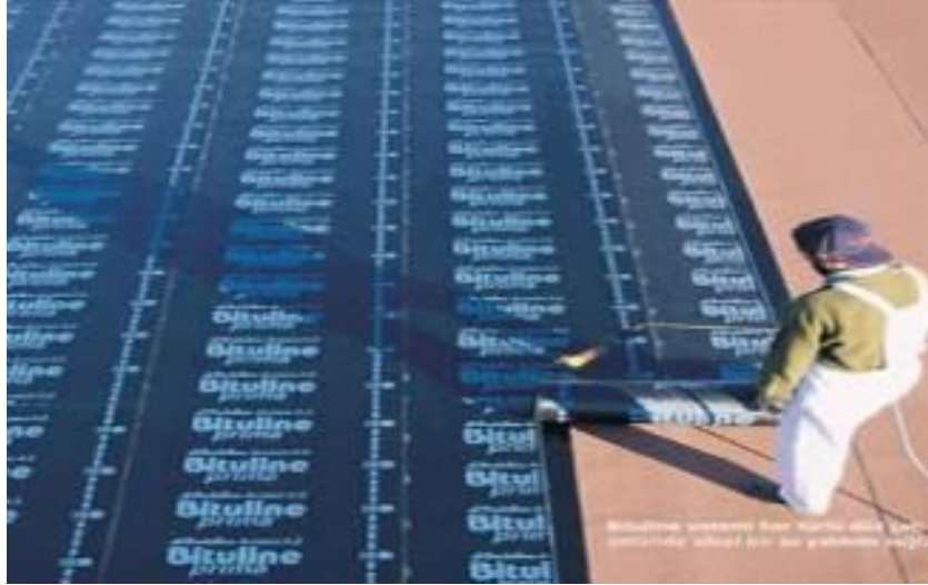
Şekil 4.34 : Teras çatıda yapılan membran uygulaması [71].
