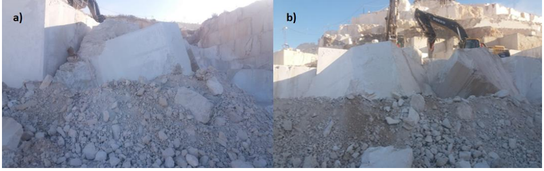
Şekil 4.8. Yastıklama üzerine yapılan yıkım örneği
