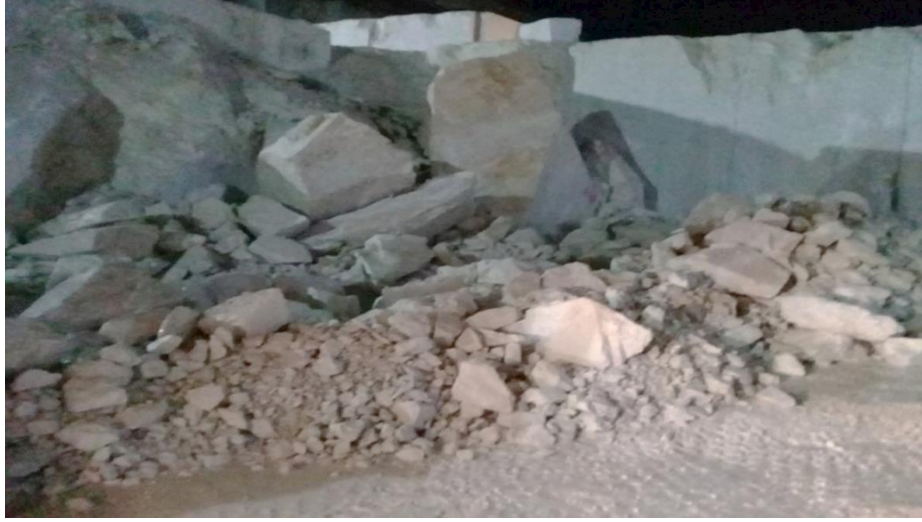
Şekil4.10. Yanlış hazırlanan yastıklama üzerine yapılan yıkım
