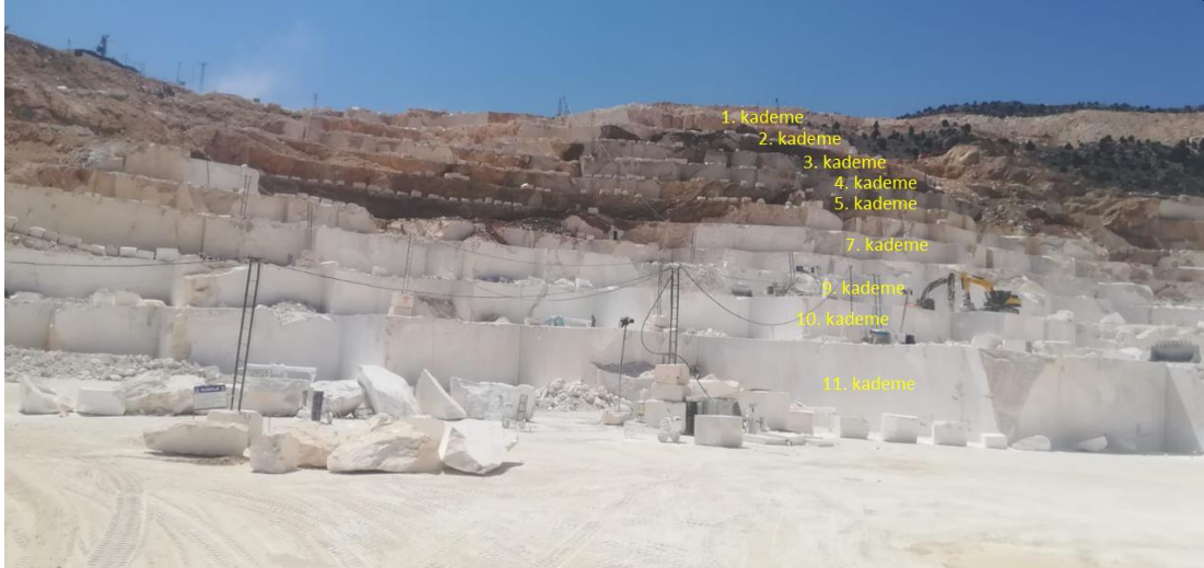
Şekil 5.1. Çalışmanın yapıldığı mermer ocağından bir görünüm
