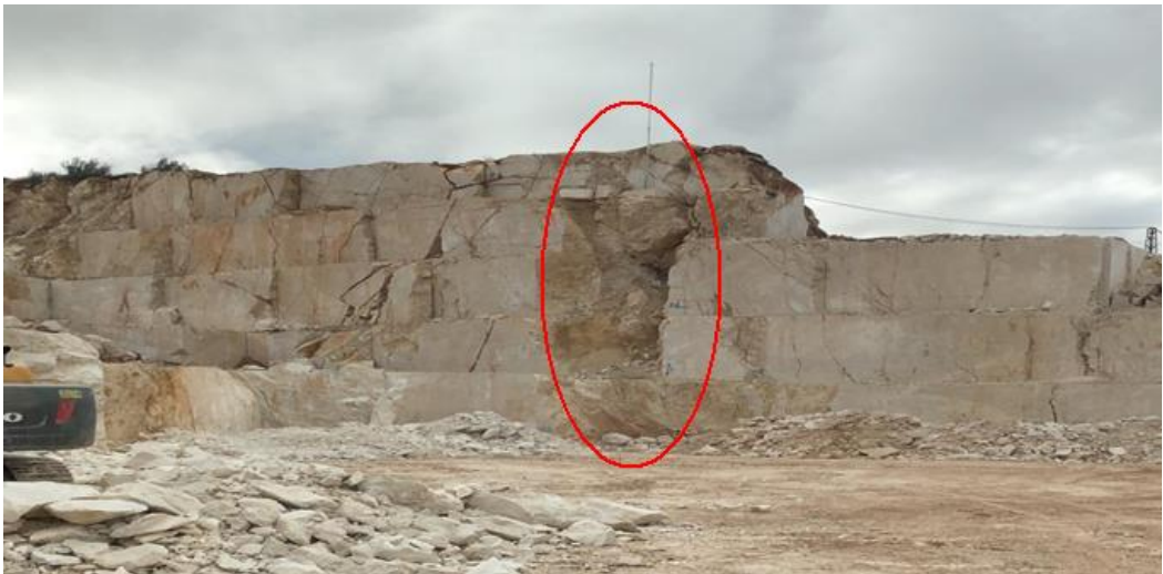
Şekil 4.1. Fay çatlaklarının görünüşü
