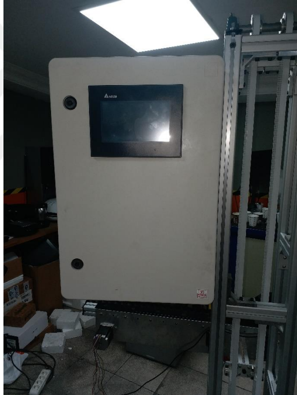
Şekil 3.15:Elektrik Pano Montajı – 1
