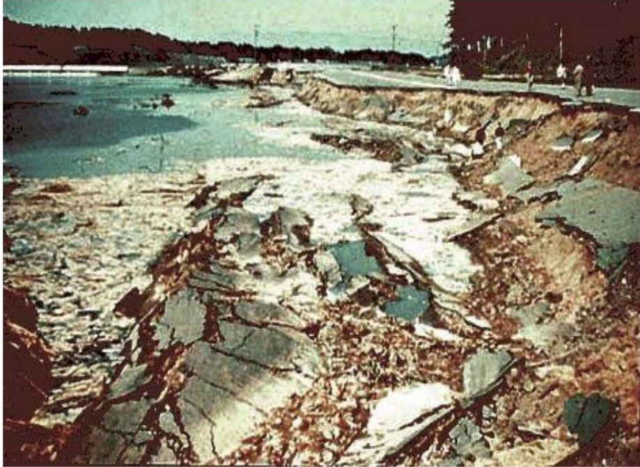
Şekil 2.3 San Francisco' da Merced gölü kıyısı boyunca 1957 yılında gelişen küçük bir akma kayması (Kramer 1996).
