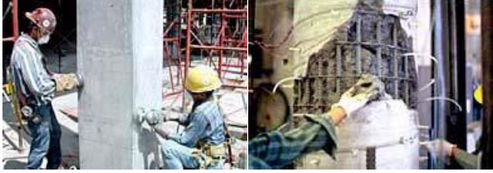
Şekil 4.11. FRP uygulaması öncesi yapılan hazırlıklar
