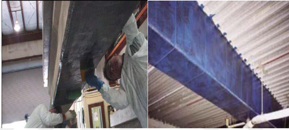
Şekil 4.13. FRP uygulaması yapılan bir kiriş
