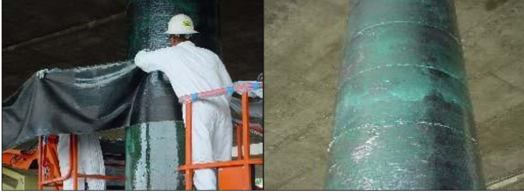
Şekil 4.12. FRP uygulaması yapılan bir kolon
