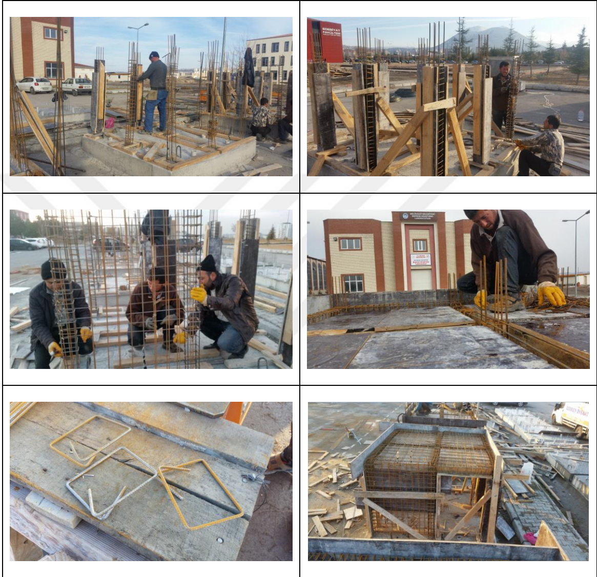
Şekil 2.29. Betonarme Taşıyıcı Sistem Numunelerinin İmalatı
