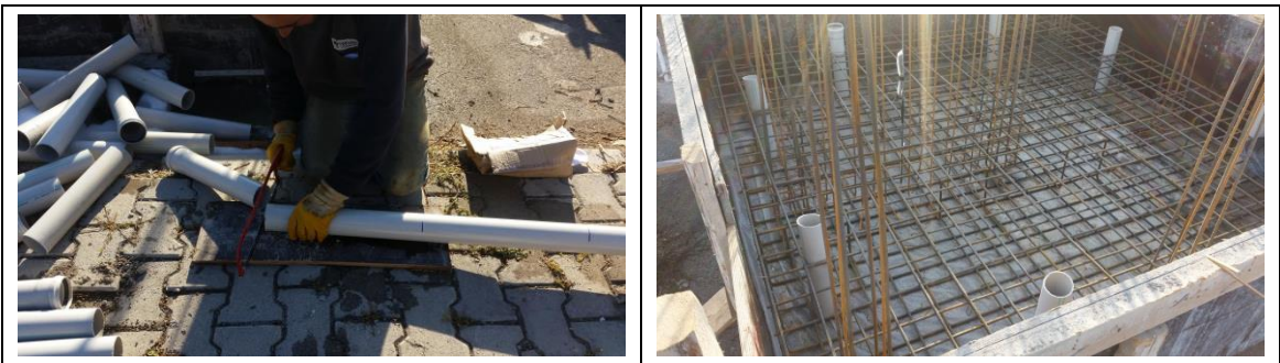
Şekil 2.24. Plastik Boruların Yerleştirilmesi
