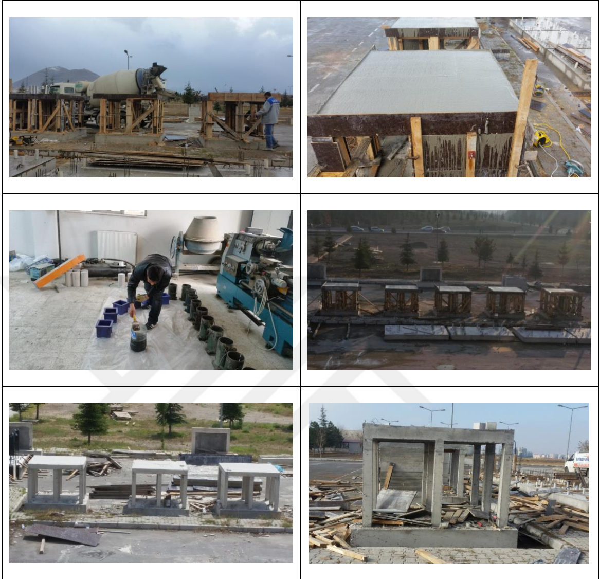
Şekil 2.30. Üst Yapı Betonunun Dökülmesi, Bakımı ve Numune alımı
