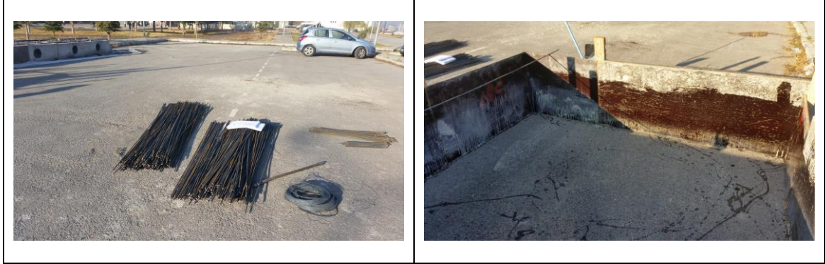
Şekil 2.20. Temel Kalıbı Yağlanması ve Temel İmalatının Donatıları
