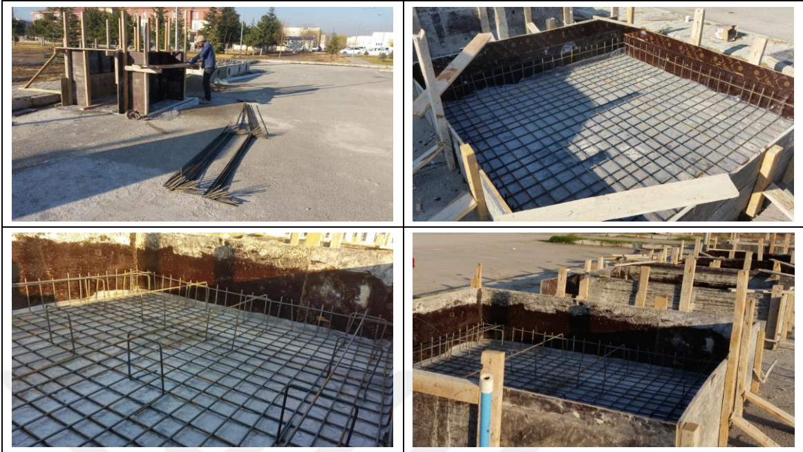
Şekil 2.22. Temel Donatılarının Yerleştirilmesi
