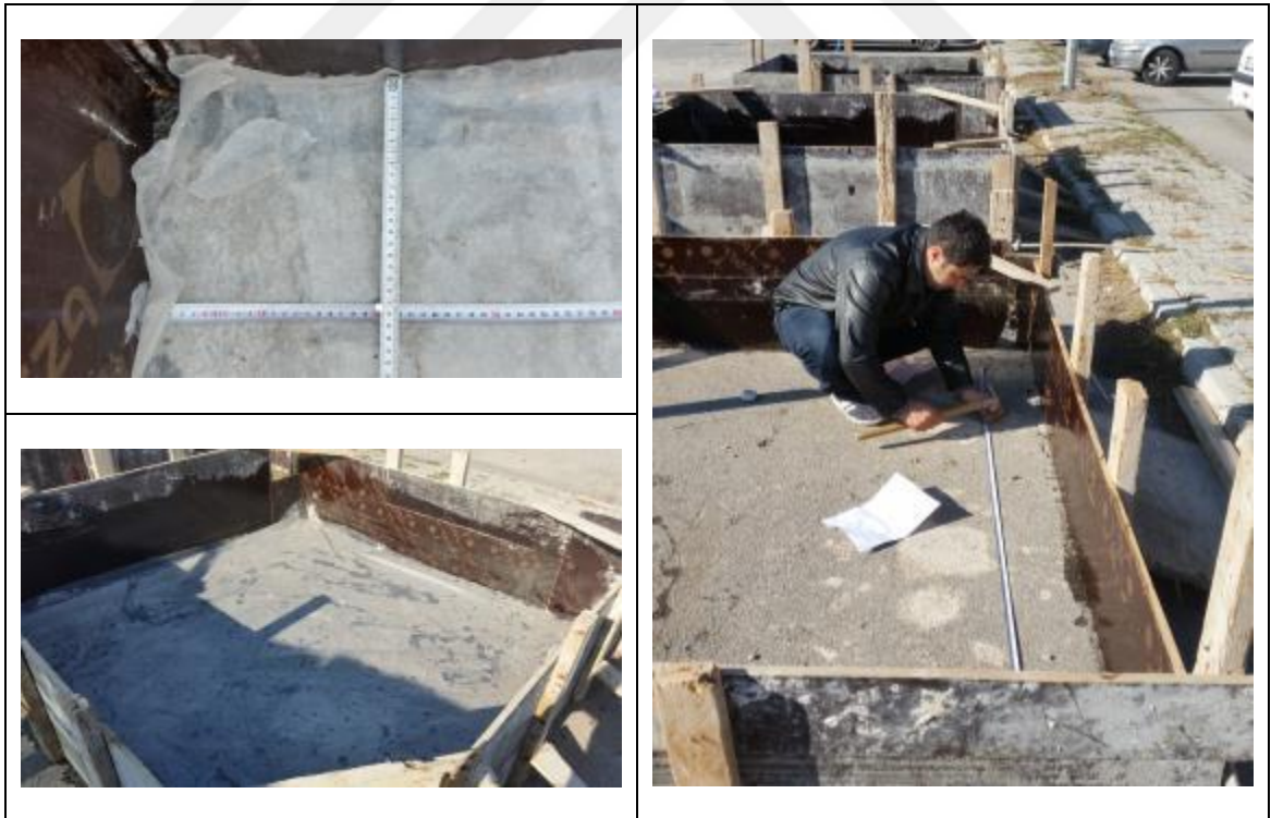
Şekil 2.21. Temel Altına Naylon Serilmesi ve Merkezlerin Belirlenmesi
