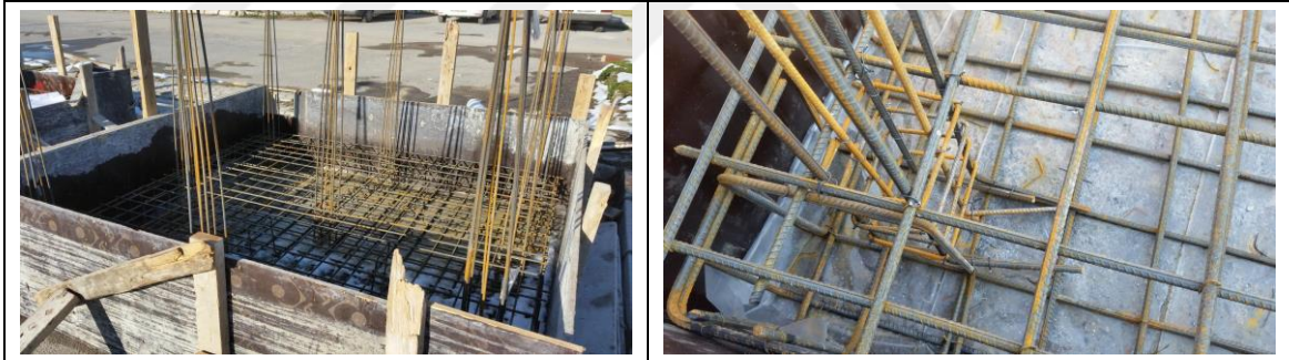
Şekil 2.23. Kolon ve Perde boyuna Donatı Yerleştirilmesi
