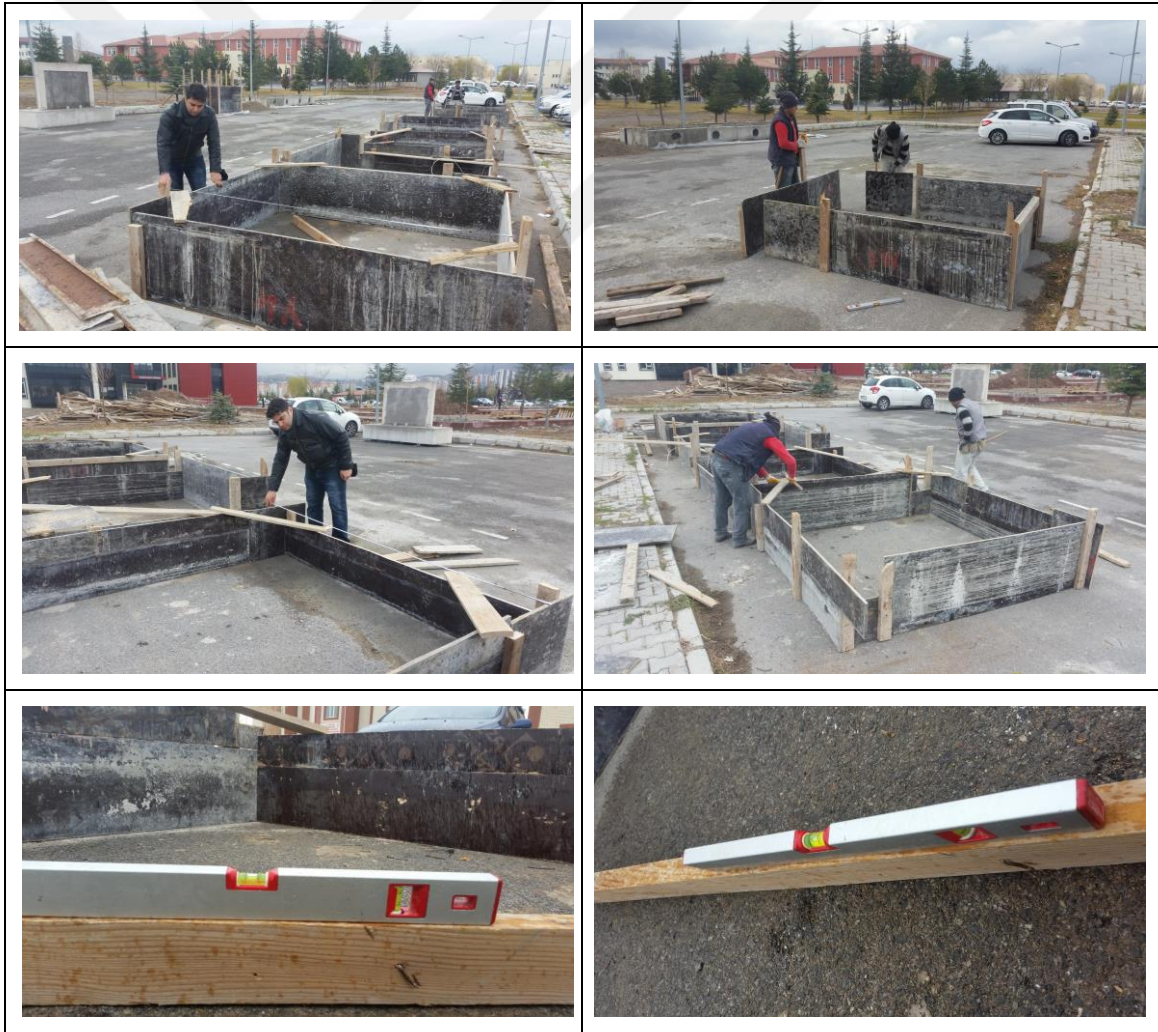
Şekil 2.19. Temel Kalıbı İmalatı
