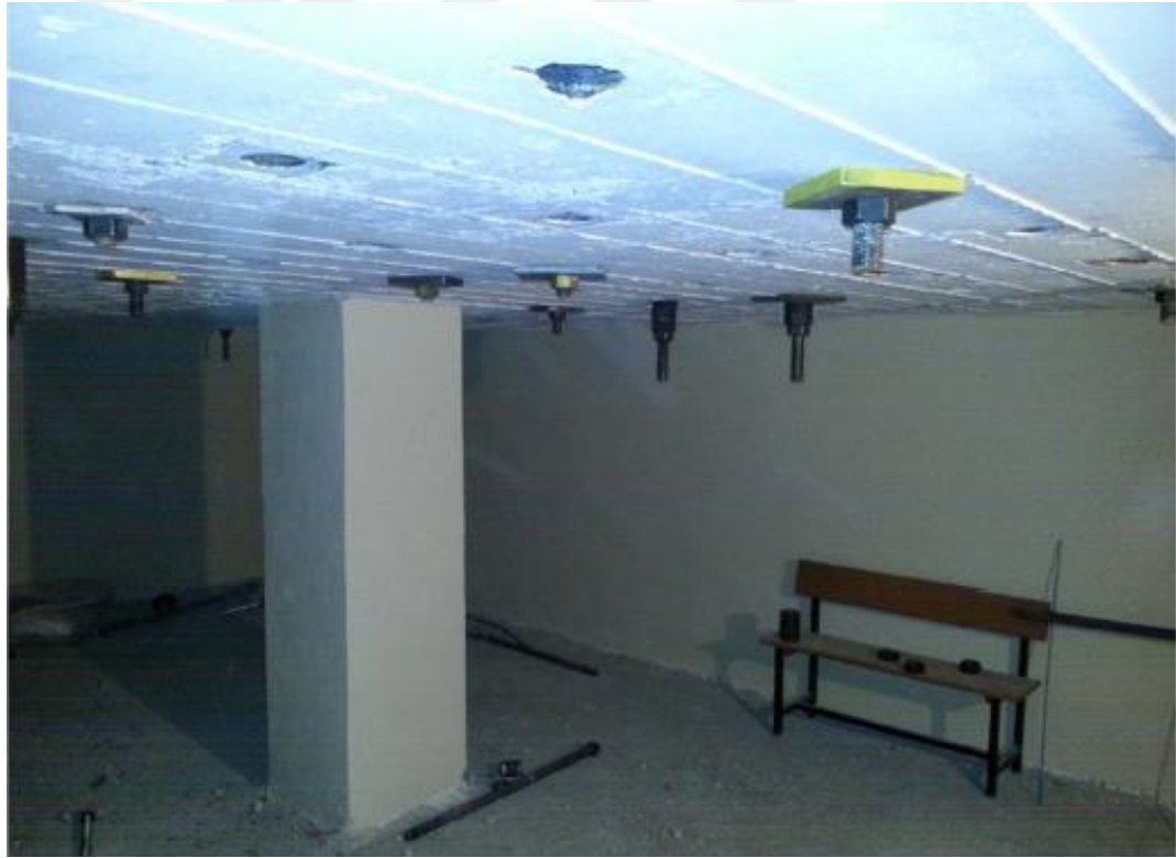
Şekil 2.72. Laboratuvar Zemin Platform Altındaki Galeri Boşluğu
