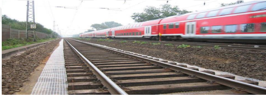
Şekil 1.52. Demiryollarında geotekstil kullanımı [19]
