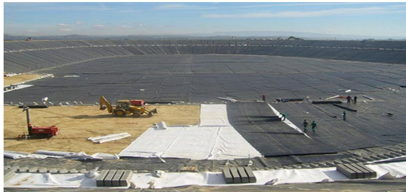
Şekil 1.53. Barajlarda geotekstil uygulaması [77]
