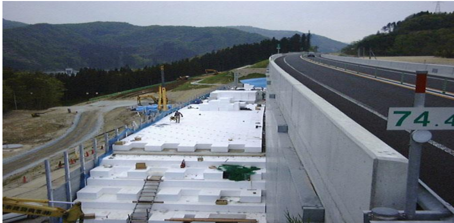
Şekil 1.9. Geofoam kullanılan otoban inşaatı, Japonya [27]
