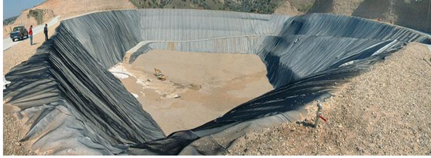
Şekil 1.49. Katı atık depolama sahasında geosentetik uygulaması [73]
