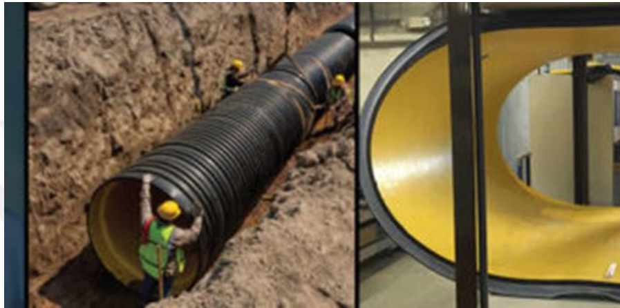
Şekil 1.3. Geoboru saha uygulaması [21]
