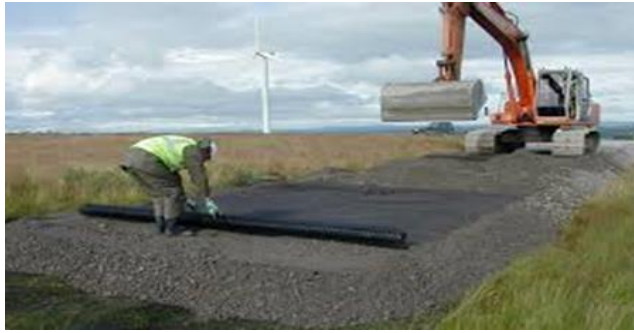
Şekil 1.50. Kaplamasız yollarda geotekstil uygulaması [74]
