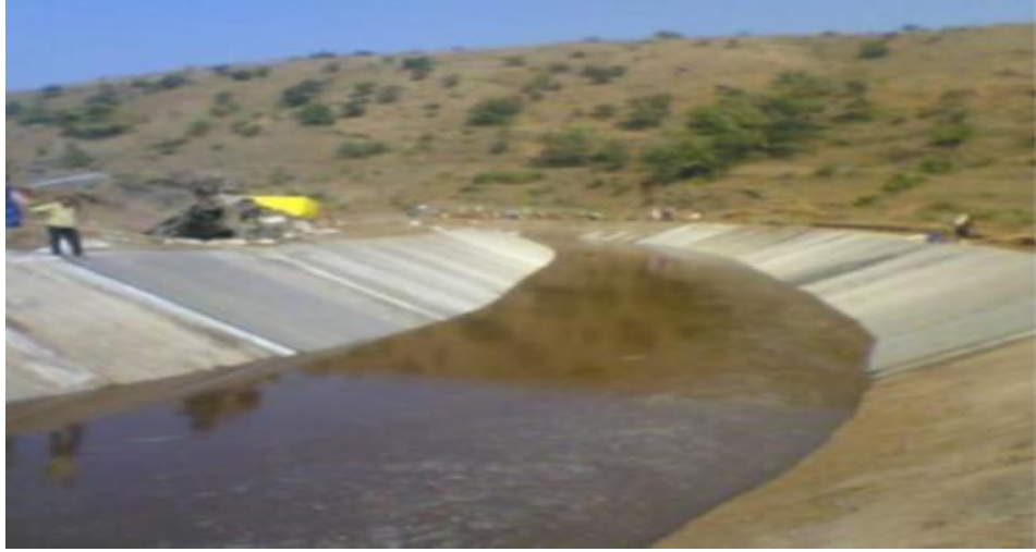
Şekil 1.2. Geomembranın astar olarak saha uygulaması [11]
