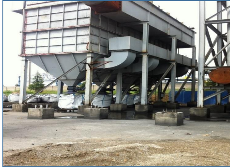
Şekil 4.11. Toz tutma tesisinin genel görünüşü
