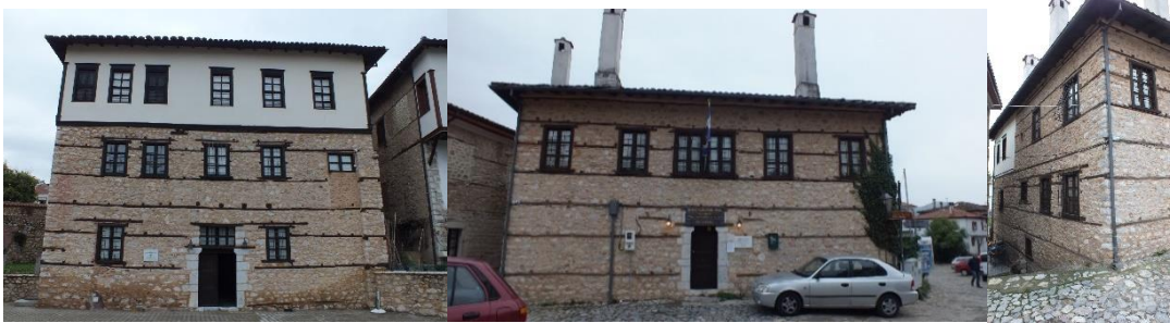
a- Güney Cephesi
