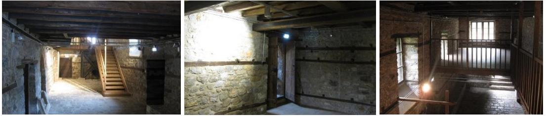
a-Zemin Kat Genel Görünümü
