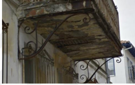
Şekil 3. 100. M. Botsari Cad. Evi Konsol Çıkma Detayı
