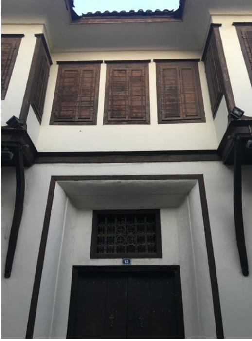
a-Batı Cephesi Girişi
