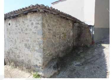
c- Kuzey Cephesi
