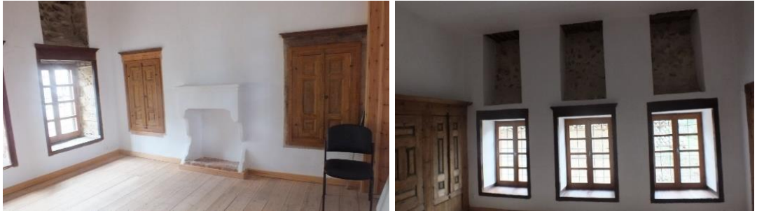
a) Ocağın Bulunduğu Duvar
