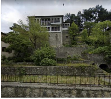
a- Kuzey Cephesi
