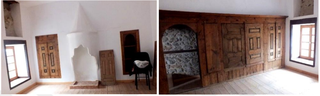
a) Ocağın Bulunduğu Duvar
