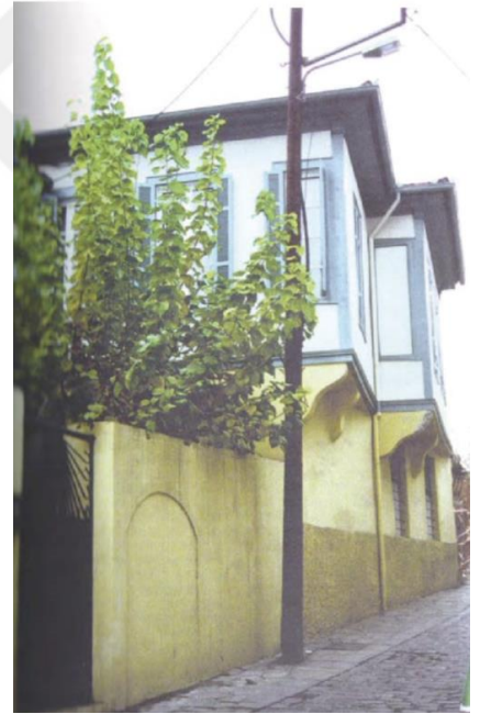
Şekil 5. 51. Akita Sokağı Numara 3 Evi Görünümü (Sotiria, 2016, s. 62)
