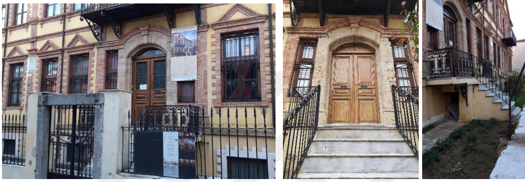
a-Giriş Kapısının Sokaktan Görünümü
