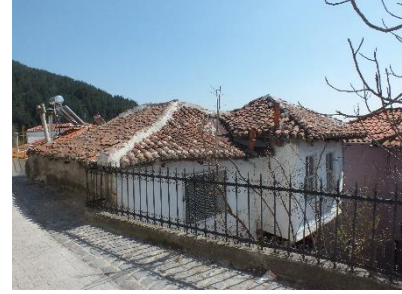
c- Kuzey Cephesi
