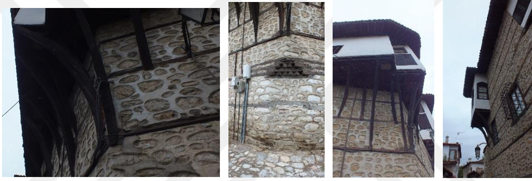
Şekil 4. 69. Emmanuel Konağı Eli Böğründe Detayları (Kesriye, 2020)
