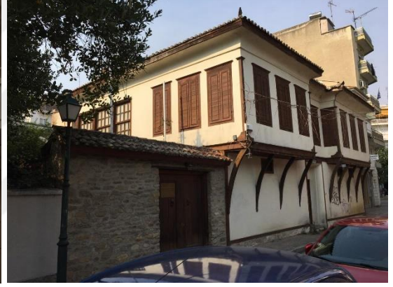
b- Güneydoğu Görünüşü
