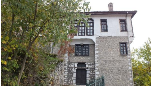
a- Batı Cephesi
