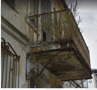
Şekil 3. 100. M. Botsari Cad. Evi Konsol Çıkma Detayı
