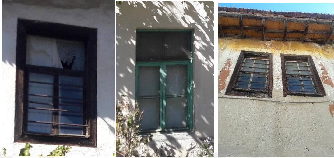
a-Güneydoğu Cephesi Pencereleri
