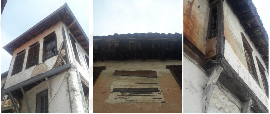
Şekil 3. 14. Karapanagiotidi Evi Yapının Cephe Detayları (İskeçe, 2020)
