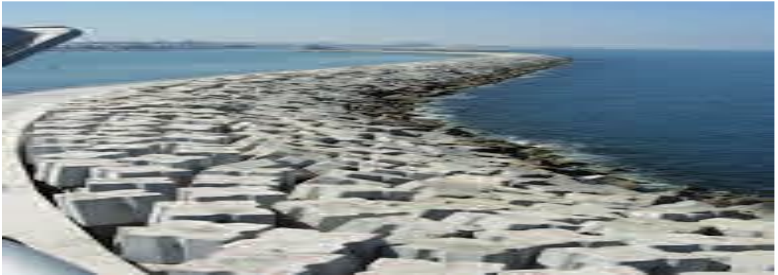
Şekil 4.14. Antifer koruma tabakalı taş dolgu dalgakıran
