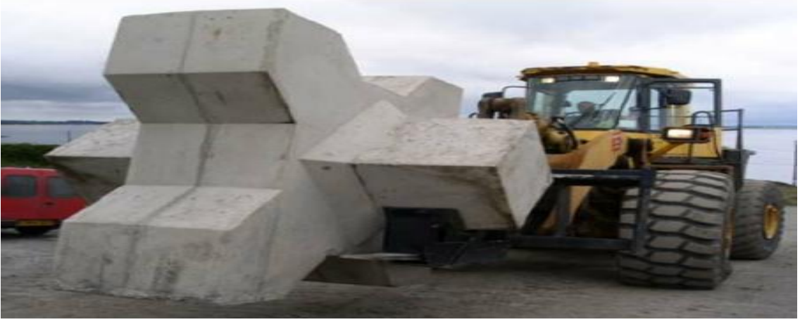
Şekil 4.21. Xbloc'ların taşınma şekli
