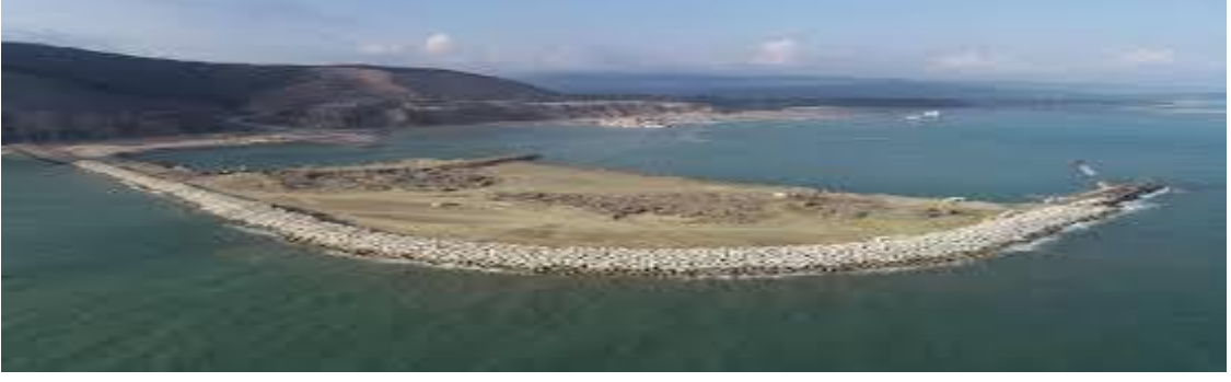
Şekil 4.17. Tek kat koruma tabakasıyla yapılan dalgakıran resimleri
