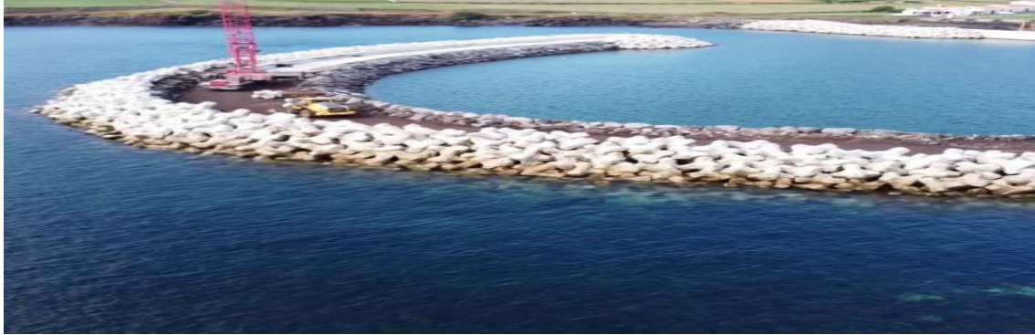
Şekil 4.19. Accropode II ile yapılmış taş dolgu dalgakıran
