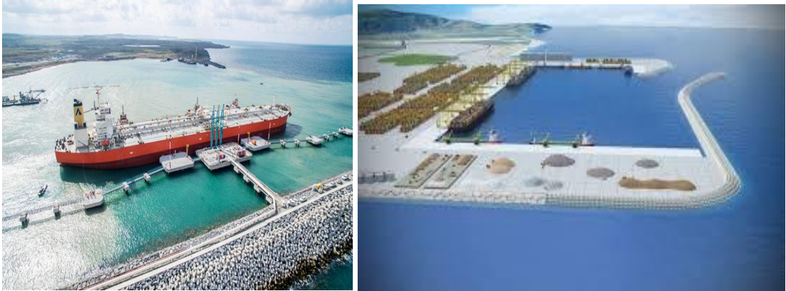
Şekil 4.16. Tek kat koruma tabakasıyla yapılan dalgakıran resimleri
