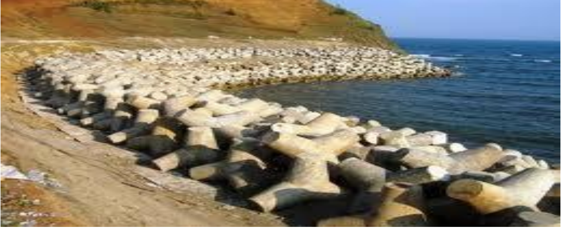
Şekil 4.12. Tetrapode koruma tabakalı taş dolgu dalgakıran
