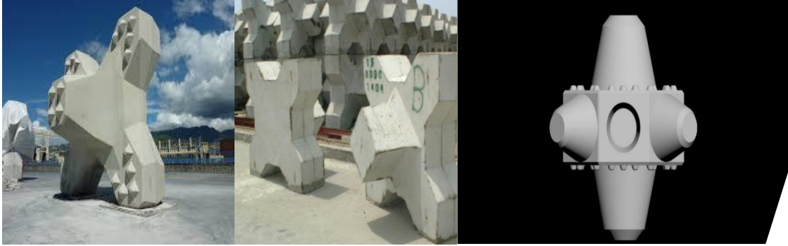
Şekil 5.4. Sırasıyla Accropode II, Xbloc ve Piblok resimleri
