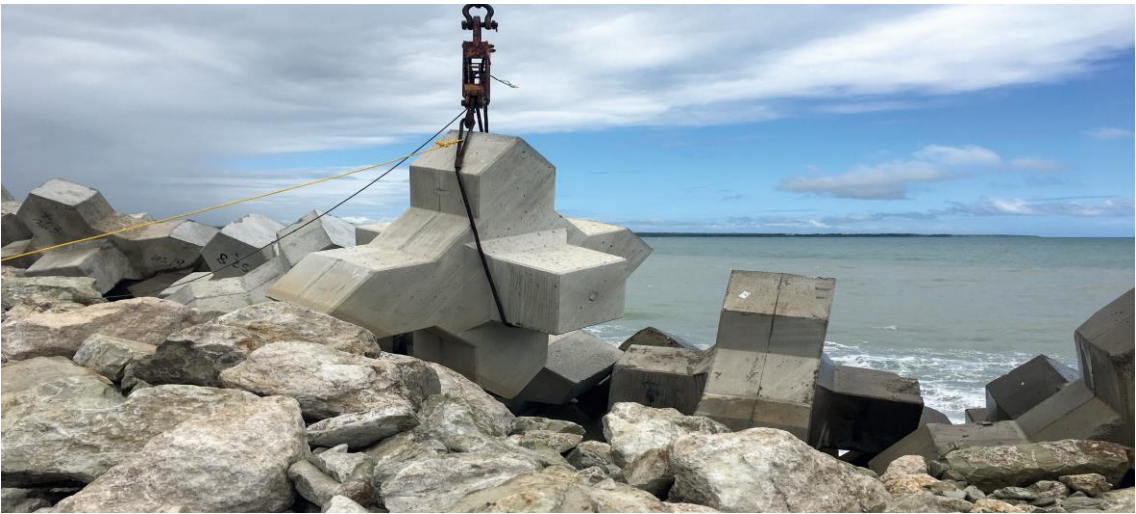
Şekil 4.22. Xbloc'ların yerleşim şekli
