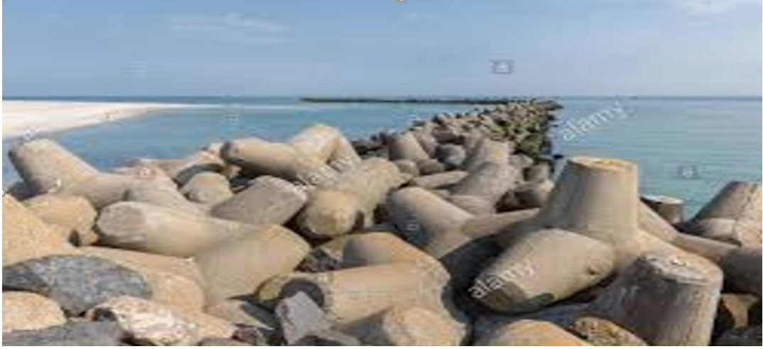
Şekil 4.13. Tetrapode koruma tabakalı taş dolgu dalgakıran
