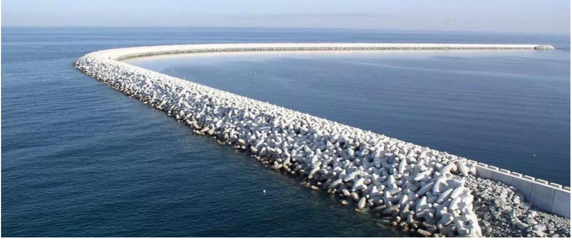
Şekil 4.15. Tetrapode koruma tabakalı taş dolgu dalgakıran
