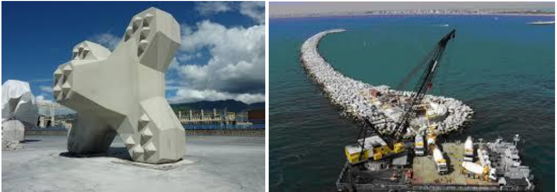
Şekil 4.18. Accropode II koruma tabakası örnekleri
