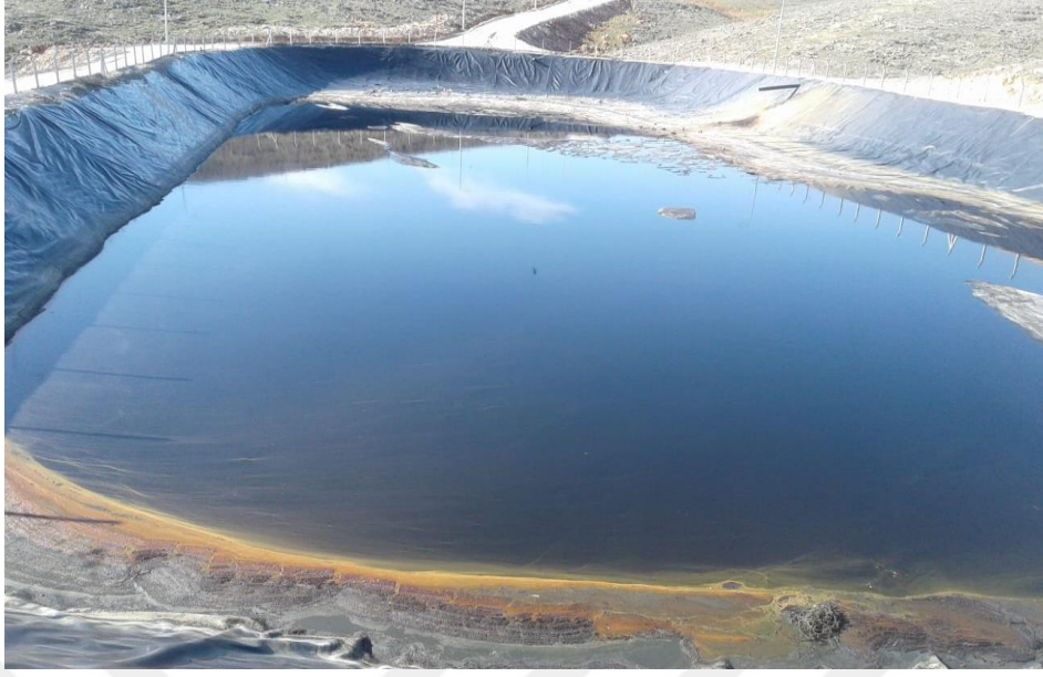
Şekil 2.4. Elazığ katı atık depolama sahası sızıntı suyu havuzu
