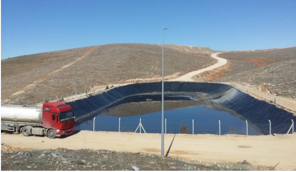
Şekil 2.5. Elazığ katı atık depolama sahası sızıntı suyu havuzunun yol kenarından görünümü
