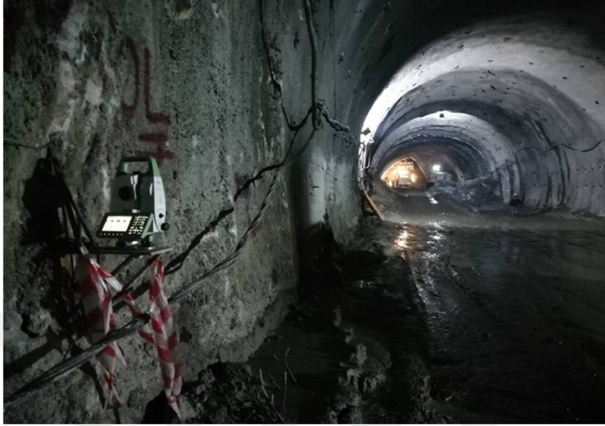
Şekil 3.38. Tünel duvarına tesis edilen poligon üzerinden ölçüm çalışması.
