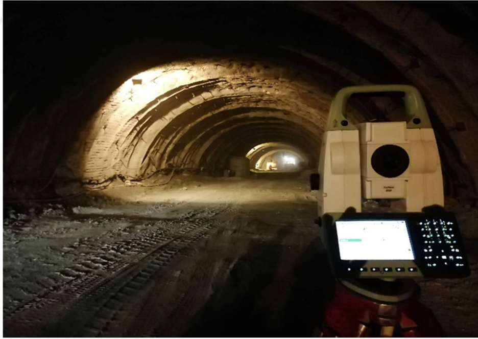
Şekil 4.25. Yüzey okuma çalışmalarına ait saha fotoğrafları (Ankara-Sivas Demiryolu Projesi T-15 Tüneli).
