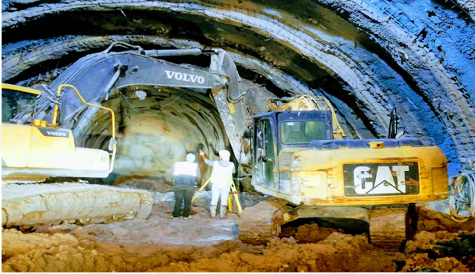
Şekil 3.41. NATM tünel açma yöntemine göre yapılan kazı çalışmasının yönlendirilmesi (Ankara-Sivas Demiryolu Projesi Tünel-15)
