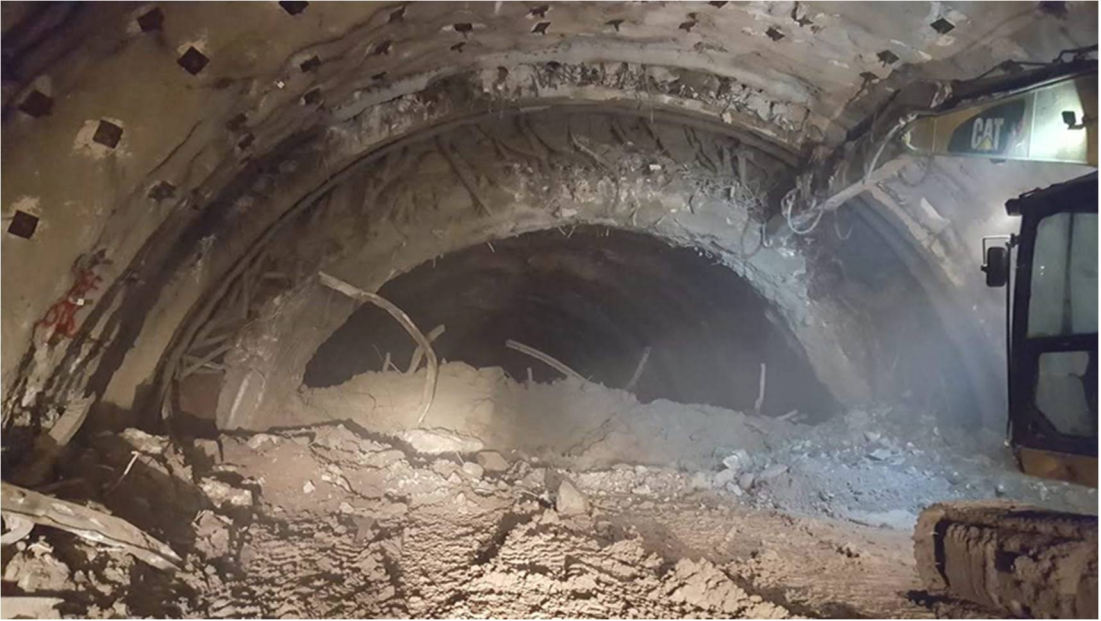
Şekil 4.35. Göçük temizleme çalışması (Ankara-Sivas Demiryolu Projesi T-15 Tüneli).
