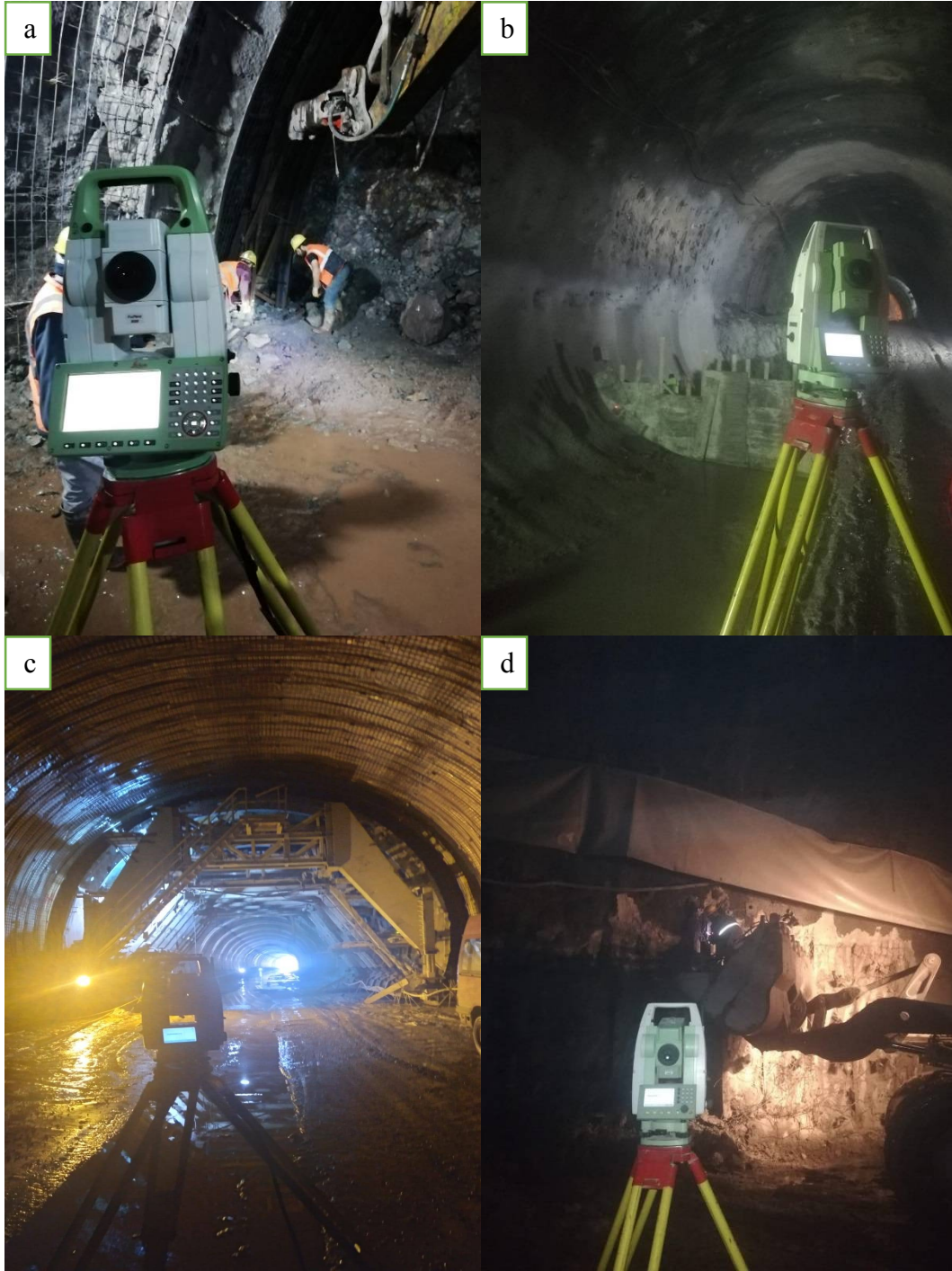
Şekil 4.17. Tünel içerisinde total station ile yapılan ölçüm çalışmaları. a) Ayna kazısının yönlendirilmesi b) İnvart kalıp kurulumu ve beton üst kotu belirlenmesi c) Tünel iç kaplama kalıbının yerleştirilmesi d) Deformasyon ölçme noktalarının projeye konumuna uygun tesis edilmesi için yer gösterimi
