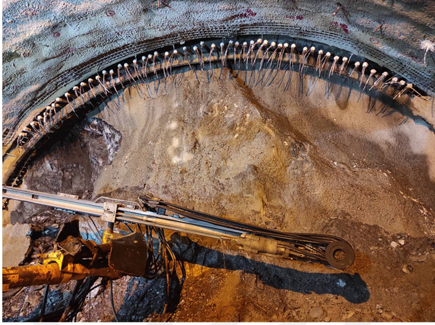
Şekil 3.29. Tünel aynasına uygulanan sürenler Şemsiye kemer (Ankara-Sivas Demiryolu Projesi T-15).
