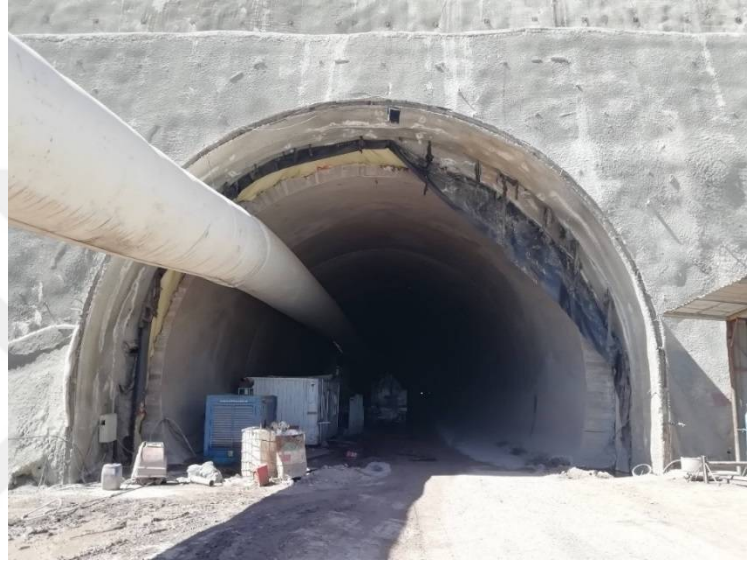
Şekil 4.5. Ana tünel giriş ağzı (Tünel-15 Çıkış).
