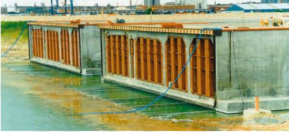
Şekil 3.36. Tüplerin yüzdürülmesi (Satır, 2007).
