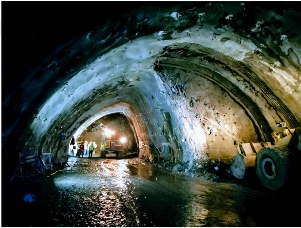
Şekil 3.26. Ankara-Sivas Demiryolu Projesi kapsamında yapımı devam eden Tünel-15'te uygulanan kafes iksa.
