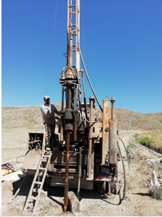
Şekil 3.3. Tünel-15 güzergâhında yapılan sondaj çalışması
