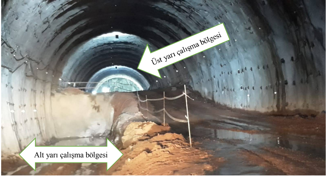
Şekil 3.7. Parçalı kesit yöntemlerinden günümüzde en çok tercih edilen NATM'a göre yapılan tünel kazı çalışması (Ankara-Sivas Demiryolu Projesi T-15 Tüneli).
