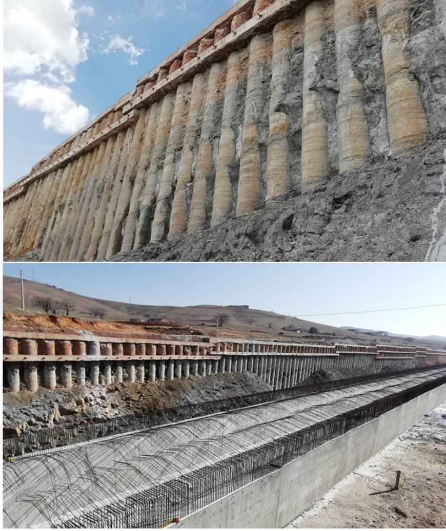
Şekil 3.33. Aç-Kapa tünel çalışması örneği (Ankara-Sivas YHT Projesi Aç-Kapa 4)
