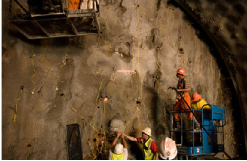
Şekil 3.34. Del – Patlat uygulamasında patlayıcıların yerleştirilmesi.
