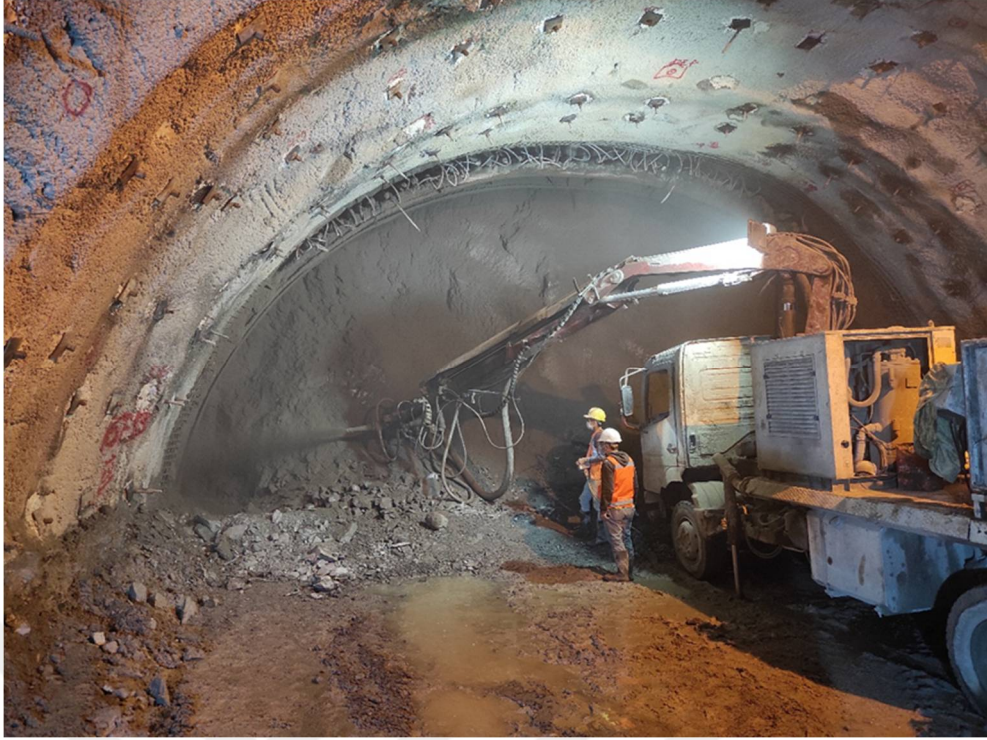
Şekil 3.24. Püskürtme betonun uygulanması (Ankara-Sivas Demiryolu Projesi T-15 Tüneli).
