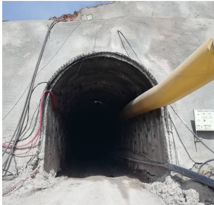
Şekil 4.6. Güvenlik tüneli giriş ağzı (Tünel-15 Güvenlik-2 Tüneli).
