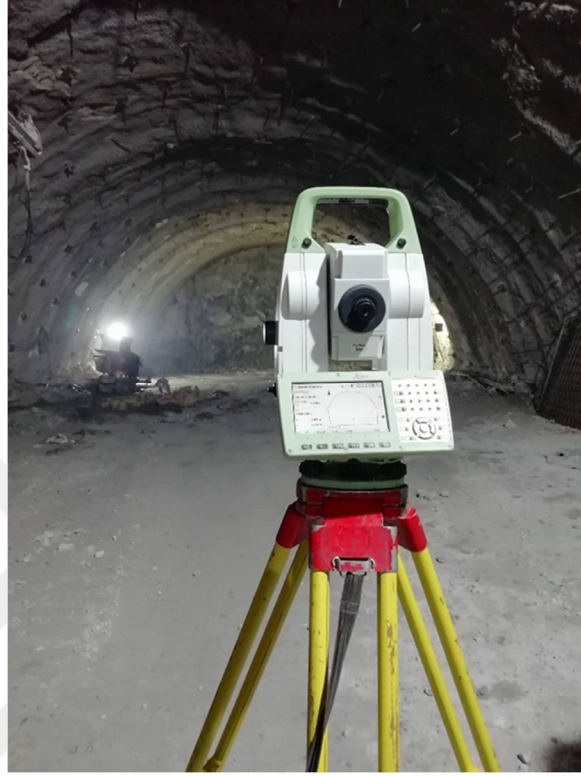
Şekil 4.21. Tünel deformasyonlarının ölçülmesi çalışmaları (Ankara-Sivas Demiryolu Projesi T-15 Tüneli).
