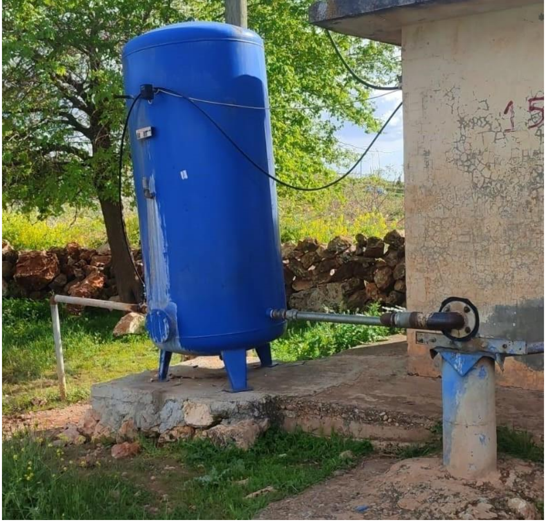
Şekil 3.6. Halfeti İlçesi Su Kuyusuna Ait Yapının Yüzeyden Görünümü
