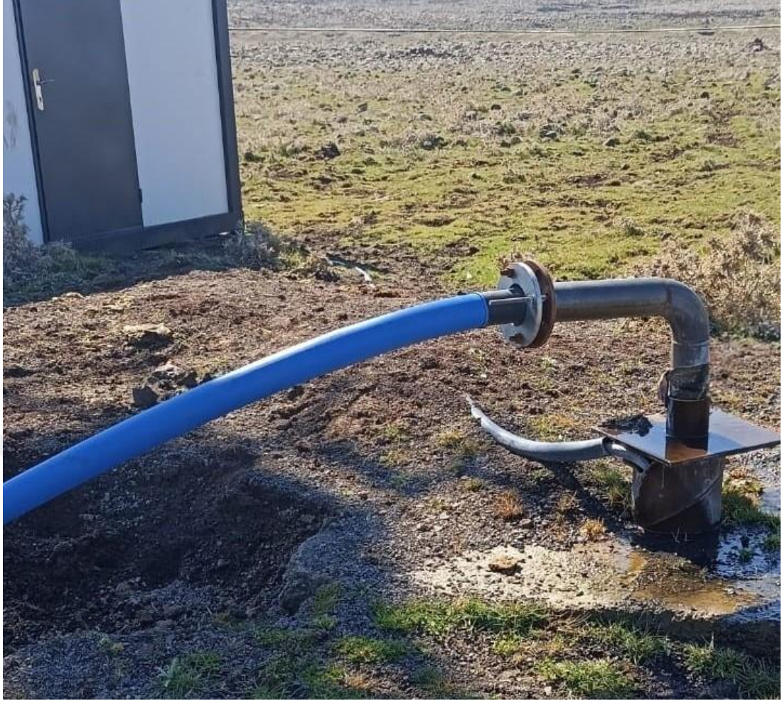
Şekil 3.12. Suruç İlçesi Su Kuyusuna Ait Yapının Yüzeyden Görünümü
