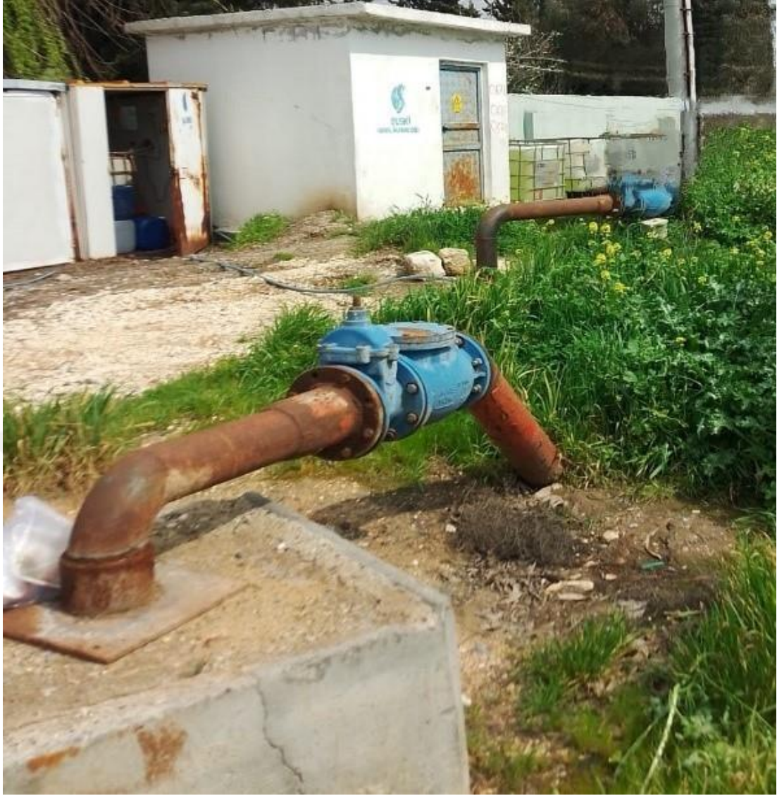
Şekil 3.2. Birecik İlçesi Su Kuyusuna Ait Yapının Yüzeyden Görünümü
