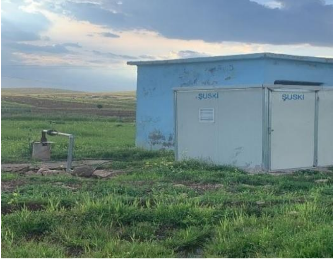
Şekil 3.5. Eyyübiye İlçesi Su Kuyusuna Ait Yapının Yüzeyden Görünümü
