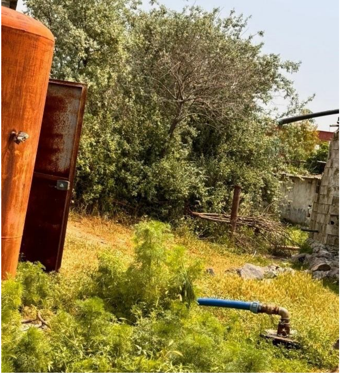
Şekil 3.8. Harran İlçesi Su Kuyusuna Ait Yapının Yüzeyden Görünümü
