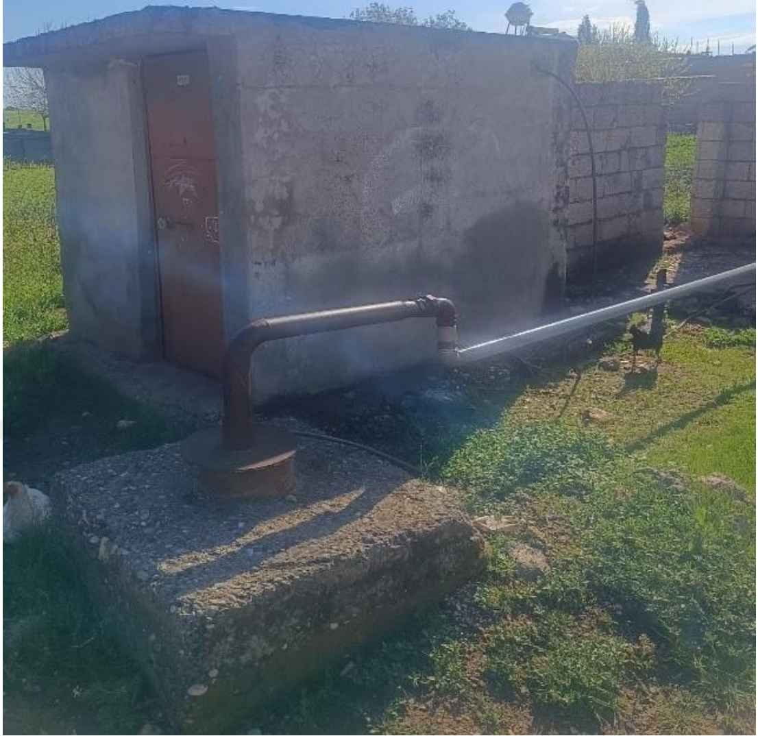
Şekil 3.9. Hilvan İlçesi Su Kuyusuna Ait Yapının Yüzeyden Görünümü
