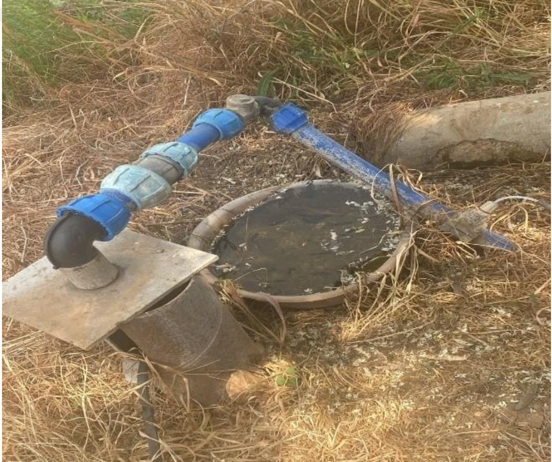
Şekil 3.10. Karaköprü İlçesi Su Kuyusuna Ait Yapının Yüzeyden Görünümü
