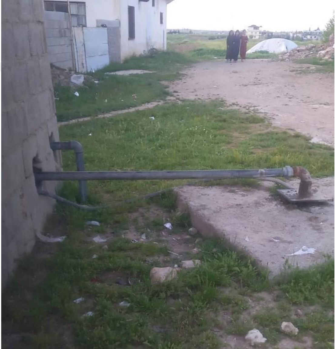
Şekil 3.4. Ceylanpınar İlçesi Su Kuyusuna Ait Yapının Yüzeyden Görünümü
