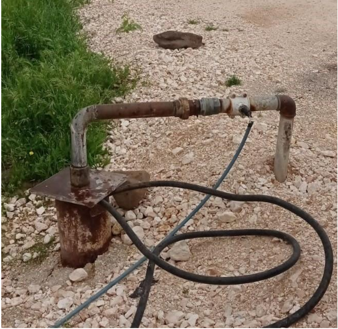
Şekil 3.7. Haliliye İlçesi Su Kuyusuna Ait Yapının Yüzeyden Görünümü
