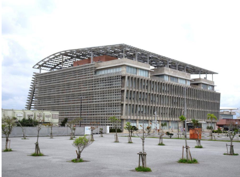
Şekil 3.17. Itoman Belediye Binası (URL-31)
