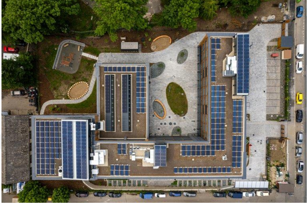
Şekil 3.14. Českokobrodská Okulu Çatı Görüntüsü (URL-22).
