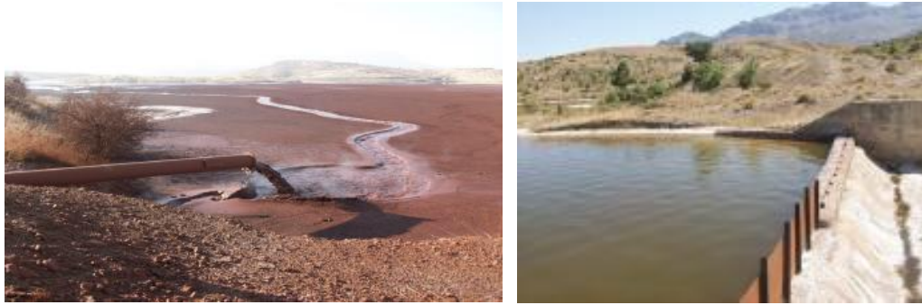
Şekil 2.5. Kırmızı çamur atık barajı (Arslan, 2016)
